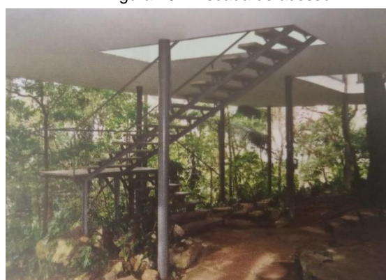
Figura 10 – Escada de acesso
