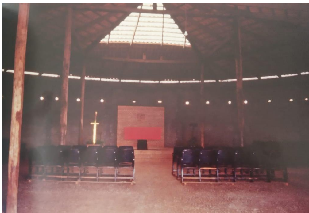
Figura 55 – Vista interna da igreja. Nota-se as aberturas proporcionadas pela retirada dos andaimes
