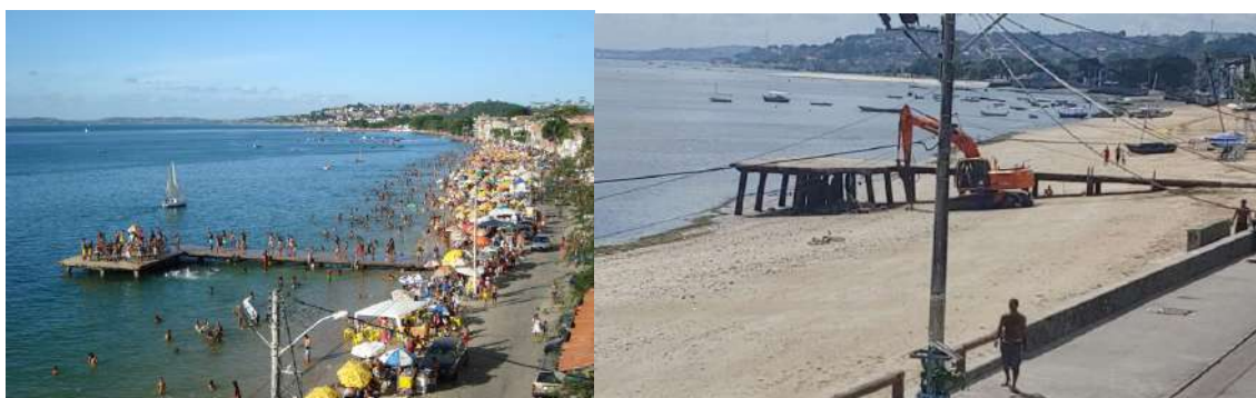
Figura 52. Ponte do Crush: à esquerda, em um dia de sol e de maré alta na Ribeira. À direita, a demolição da ponte, com a maré baixa. Fonte: Diego Mascarenhas e Itapagipe Online.
