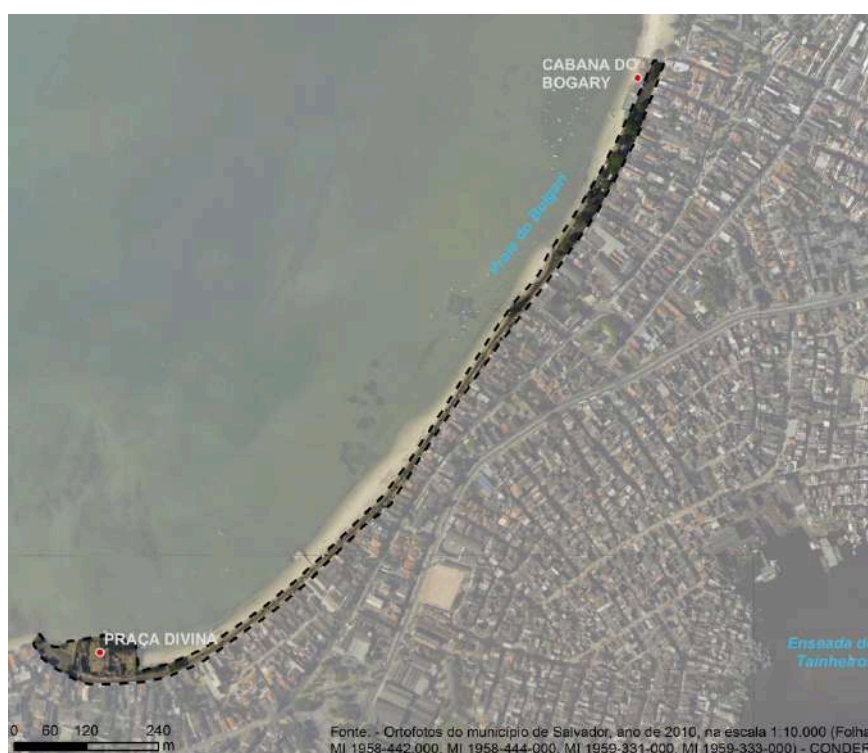
Figura 60. Trecho da obra realizada na Ribeira entre 2013 e 2015. Fonte: SOUZA (2017).
