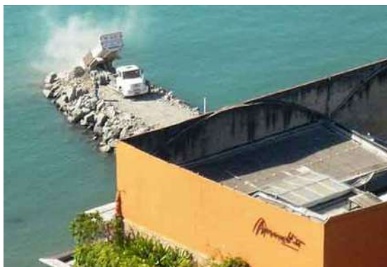
Figura 55. Construção de quebra-mar próximo ao Restaurante Amado. Fonte: Varela Notícias (2013).
