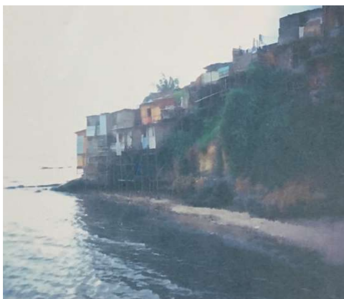
Figura 46. Palafitas em Pedra Furada antes da construção da pista de borda. Fonte: SALVADOR, 2008[?].
