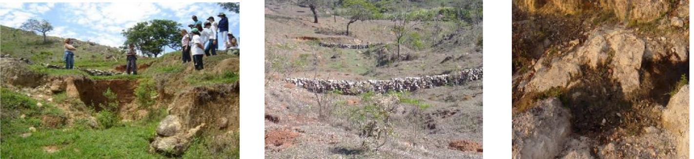
Em A, uma das nascentes sob forte processo erosivo, em B a contenção da erosão pelo enrocamento e, em C, o início da recuperação.
