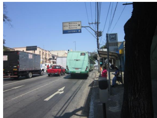
Ponto de ônibus sem recuo da calçada
