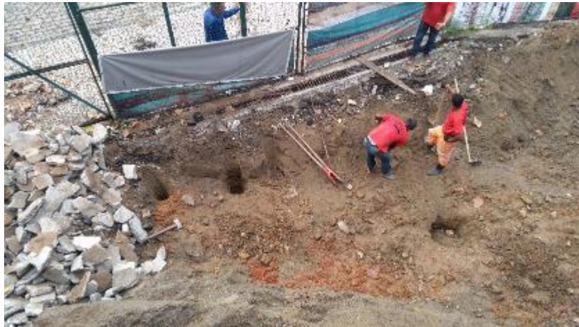
Figura 40: Buracos para drenagem
