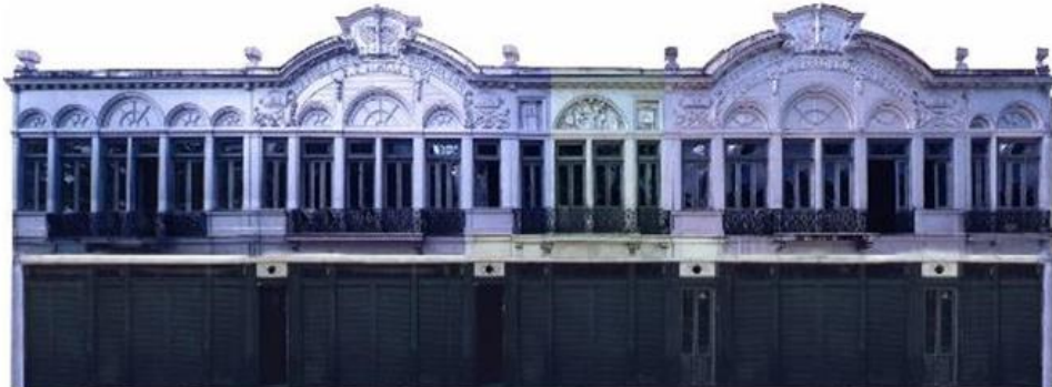
Fachada após a reforma da dec. de 1990
