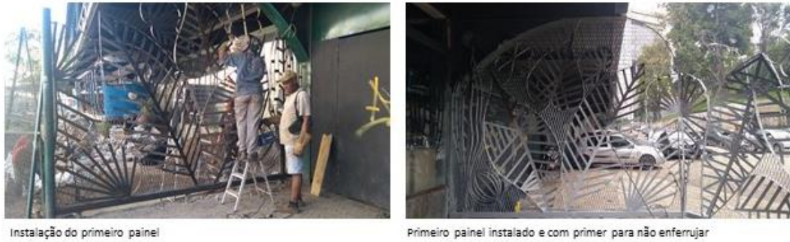
Figura 24: Mosaico de fotos do processo produtivo da grade
