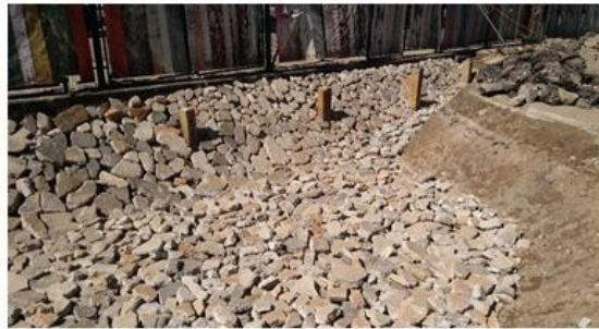
Camadas de pedra de concreto no fundo e parede que recebe água no canteiro 2
