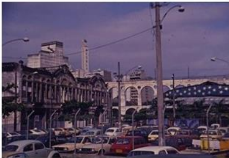
Fachada antes da reforma da dec. de 1990
