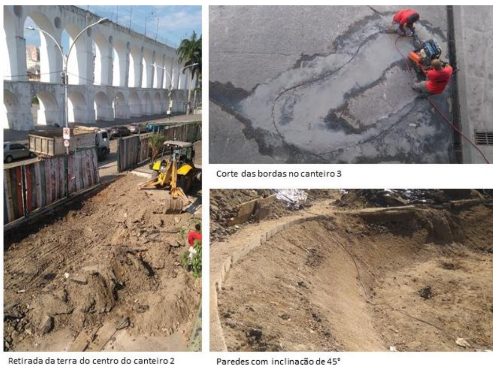
Figura 39: Mosaico de fotos do processo de escavação
