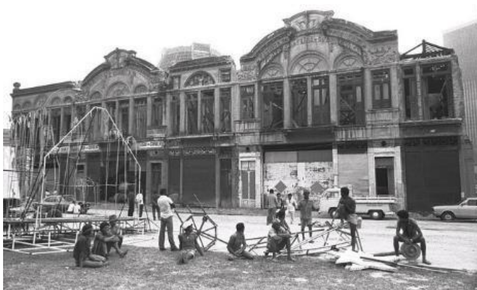
Figura 9: Fachada da Fundação Progresso antes da reforma
