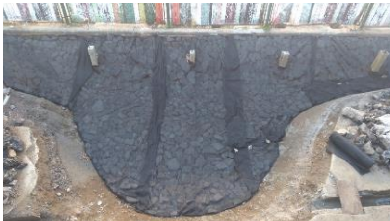
Figura 43: Sombrite instalado no canteiro 2
