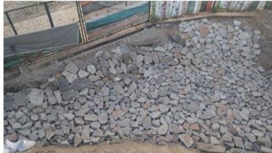
Camadas de pedra de concreto no fundo e parede que recebe água no canteiro 1
