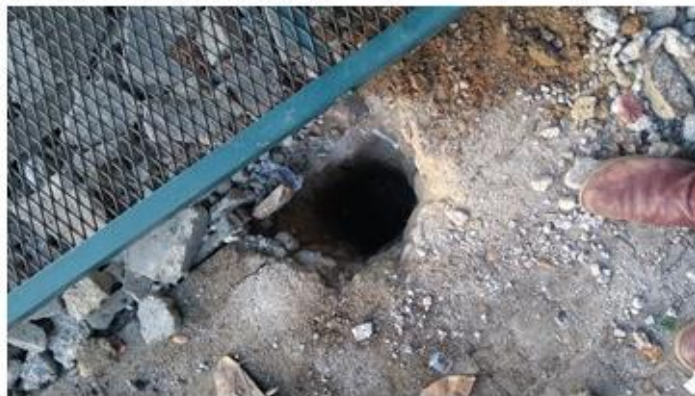
Buraco para receber as peças de fundação
