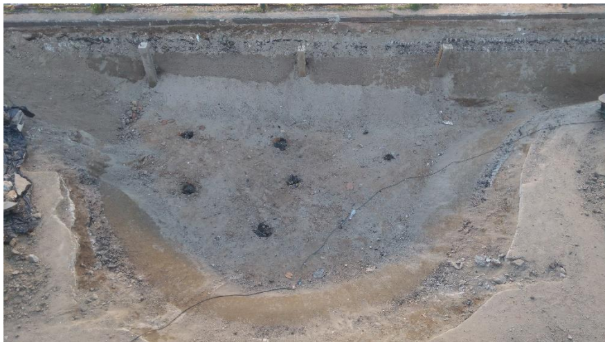
Figura 41: Colunas de concreto para receber o tirante da grade
