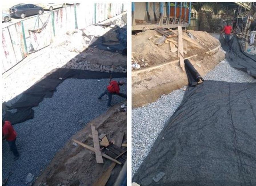
Camada de brita no canteiro 2
