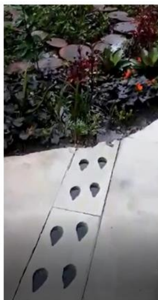
Canaleta conduzindo a água do jardim 1 para o jardim 2
