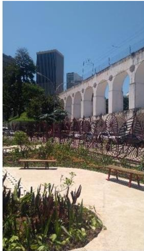
Jardins e grades concluídos
