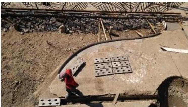
Colocação das placas
