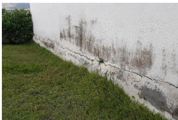
Figura 5.11 - Umidade ascendente e fissura na interface manta/reboco
