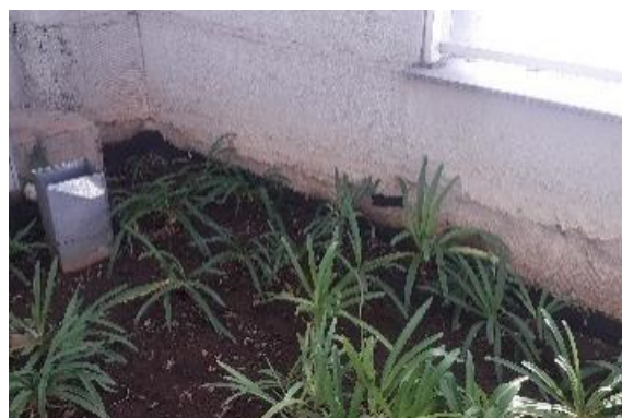
Figura 5.11 - Umidade ascendente e fissura na interface manta/reboco
