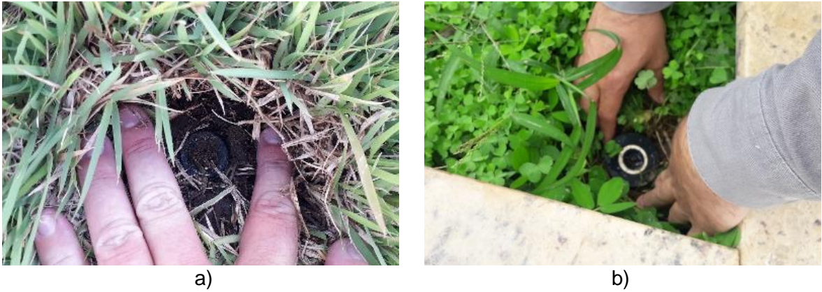
Figura 5.8 - Abafamento do sistema de irrigação
