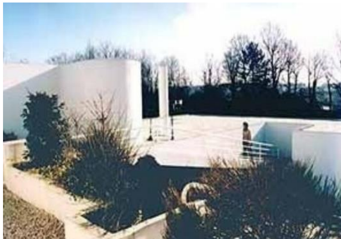
Figura 3.7 - Villa Savoye construída em 1928 na cidade de Poissy na França. Vista geral da cobertura e rampa de acesso ao terraço. Foto: Carlos Alberto Maciel
