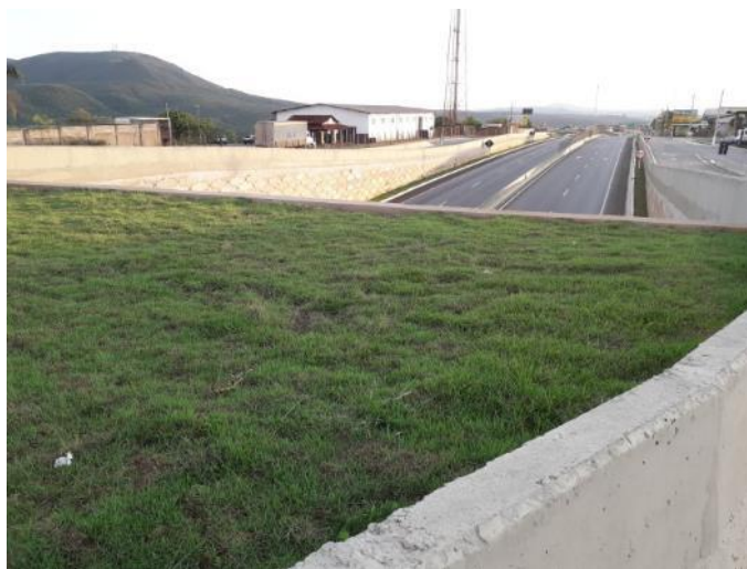
Figura 3.2 - Telhado verde sobre viaduto na MG 050 - Km 75 na cidade de Mateus Leme em Minas Gerais
