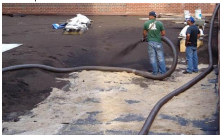
Figura 3.49 - Equipamentos utilizados para transporte vertical de materiais. a) Lançamento de substrato por guindaste; b) Lançamento de substrato por bomba pneumática
