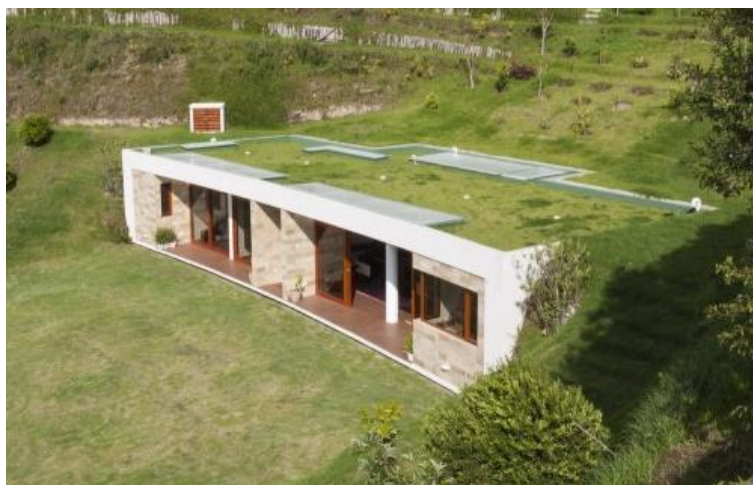
Figura 3.14 - Lookout House. Exemplo de telhado verde extensivo
