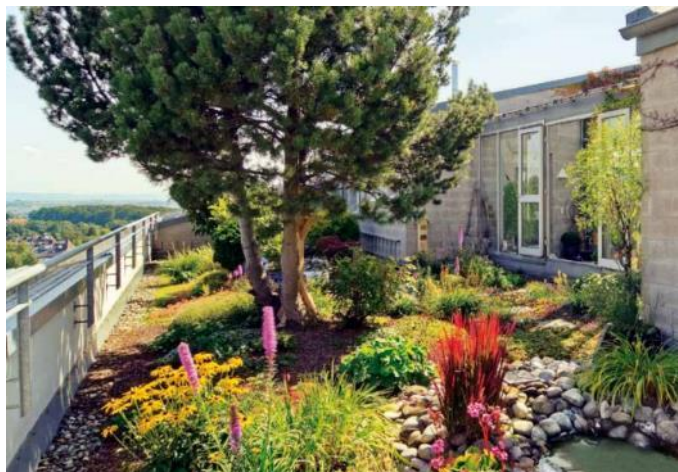
Figura 3.12 - Telhado verde intensivo com grande variedade de espécies e tamanhos de plantas
