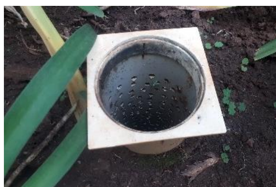
Figura 5.7 – Ausência de lastro de material granular no entorno das coletas de drenagem
