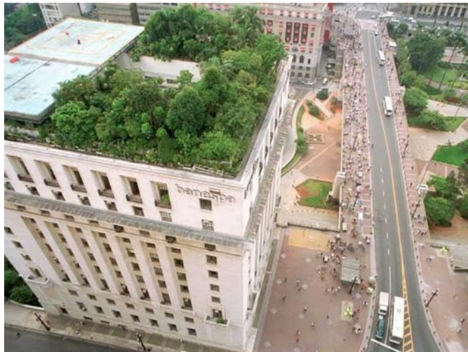
Figura 3.9 - Edifício Matarazzo em São Paulo
