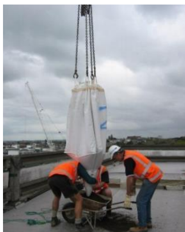
Figura 3.49 - Equipamentos utilizados para transporte vertical de materiais. a) Lançamento de substrato por guindaste; b) Lançamento de substrato por bomba pneumática
