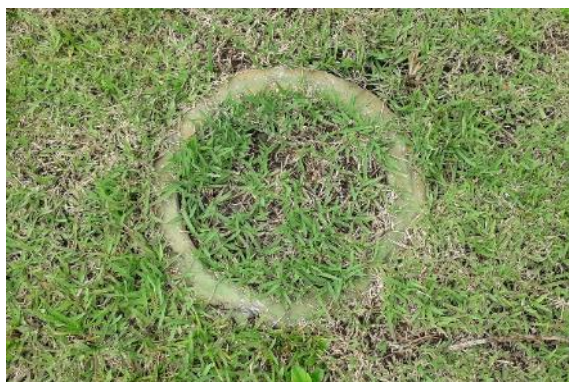
Figura 5.6 - Abafamento do sistema de drenagem pela vegetação do entorno
