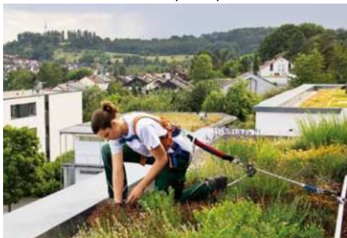
Figura 3.50 - Sistema contra queda para trabalhos em altura
