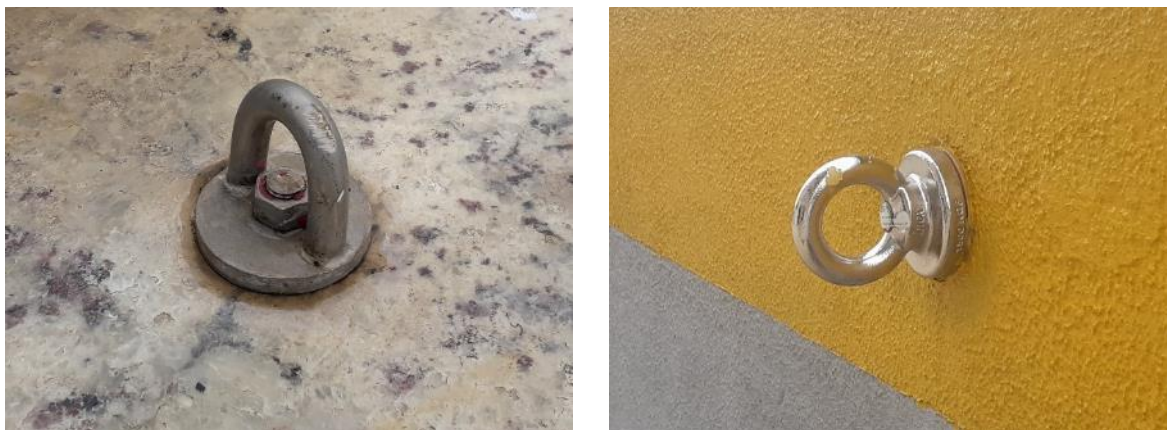
Figura 3.52 - Ponto de ancoragem para proteção contra quedas em trabalhos em altura
