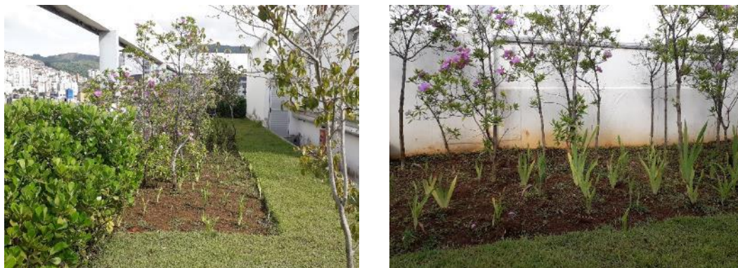
Figura 5.4 - Remoção de massa morta e replantio de mudas
