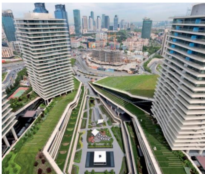
Figura 1.1 - Exemplo de uma cobertura com várias funções que vão além da simples vedação horizontal
