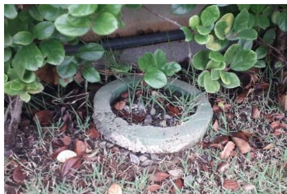
Figura 5.6 - Abafamento do sistema de drenagem pela vegetação do entorno
