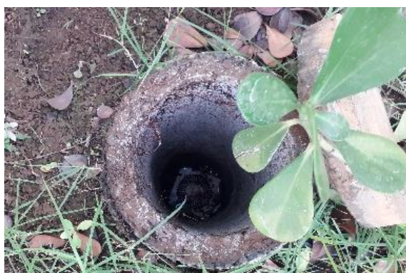
Figura 5.7 – Ausência de lastro de material granular no entorno das coletas de drenagem
