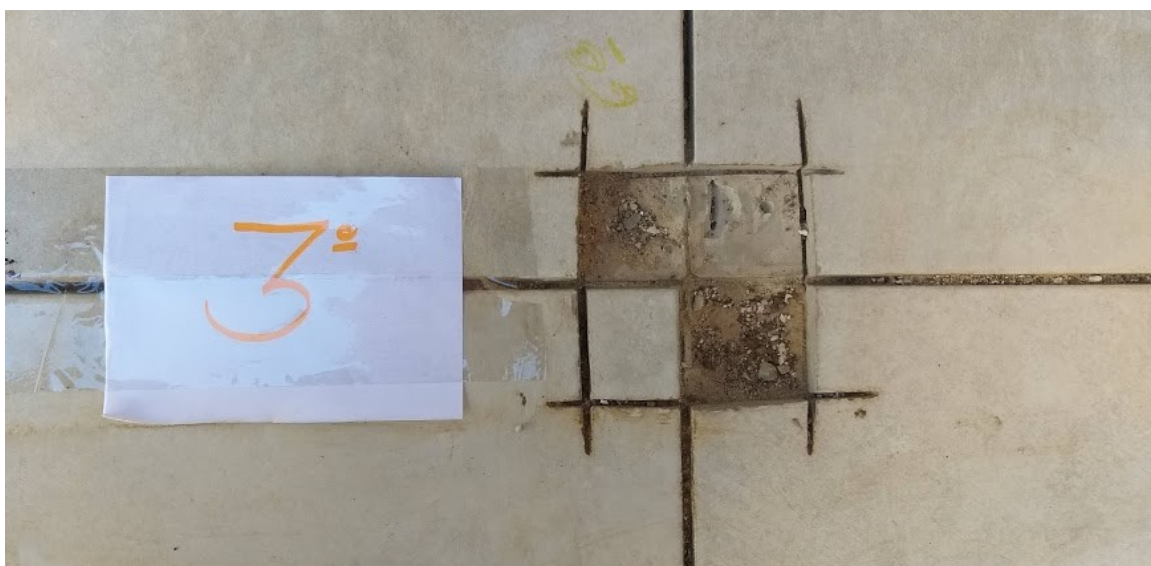
Figura 40 – Forma de ruptura do terceiro corpo de prova da argamassa C
