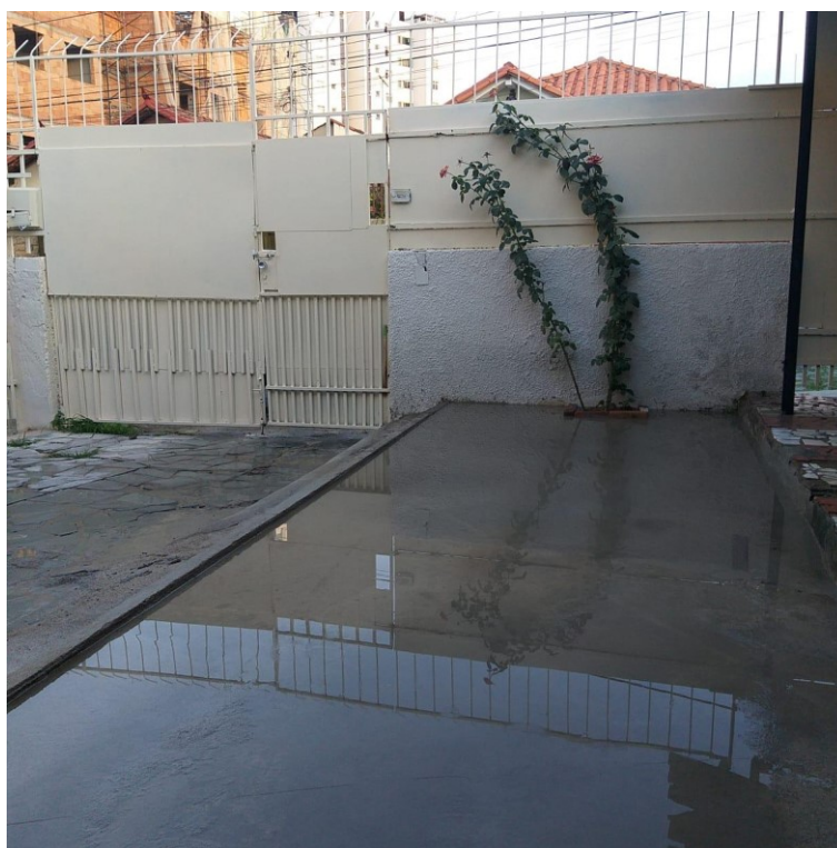
Figura 03 - Cura úmida laje de piso
