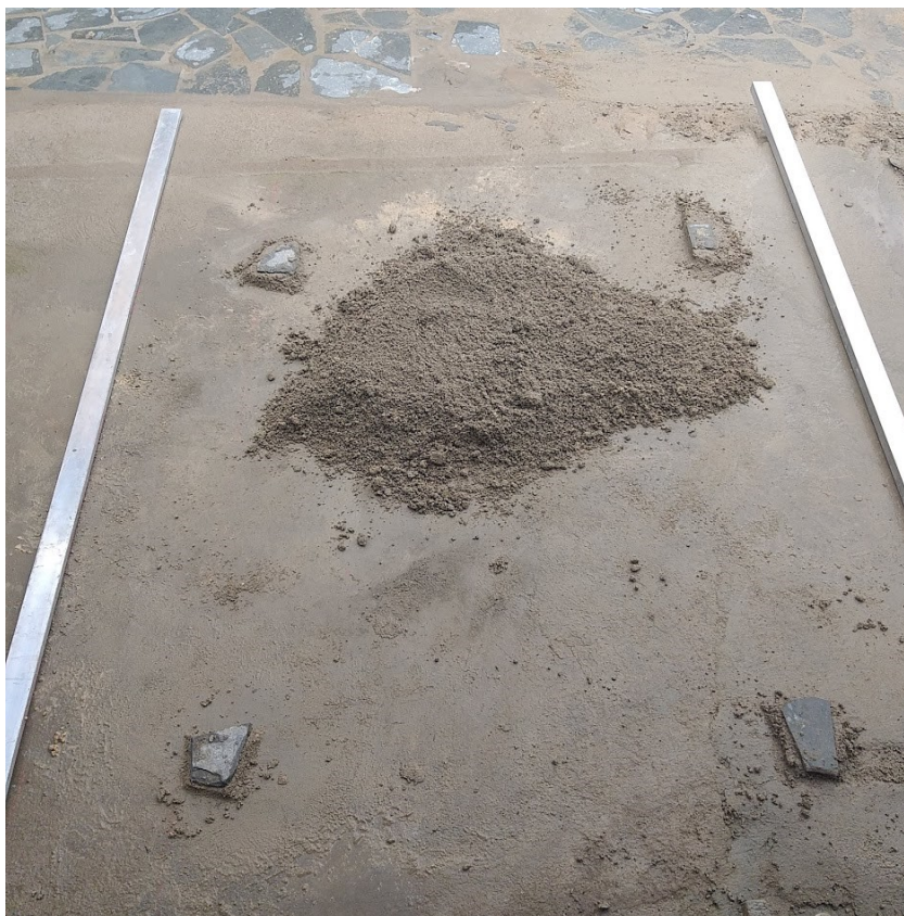
Figura 08 - Execução de taliscas para delimitação da altura da argamassa de contrapiso
