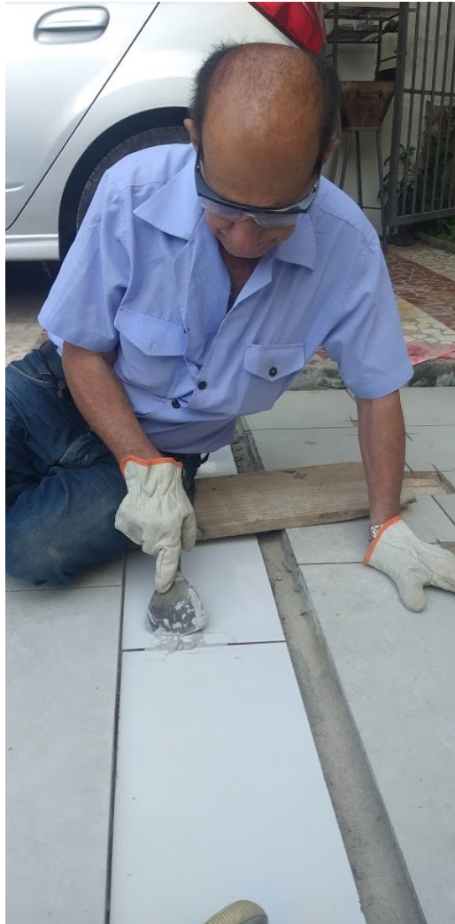
Figura 19 - Rejuntamento das placas cerâmicas.
