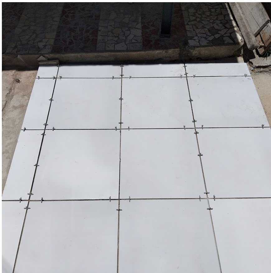
Figura 15 - Juntas de Assentamento do revestimento cerâmico.
