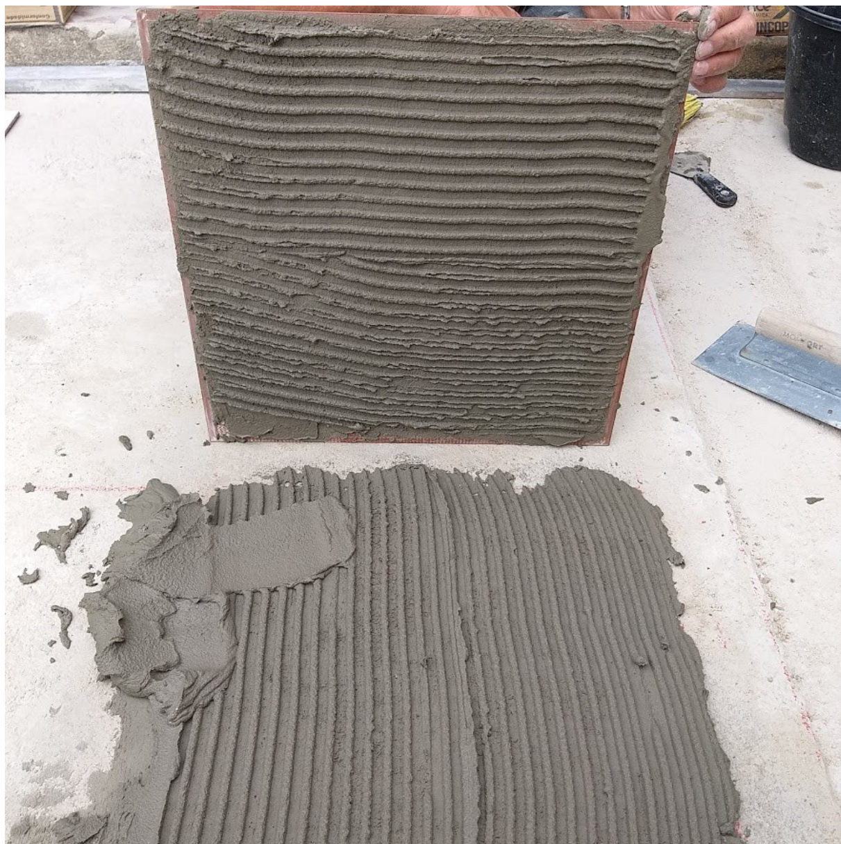
Figura 14 - Aplicação de argamassa colante no tardo da placa cerâmica
