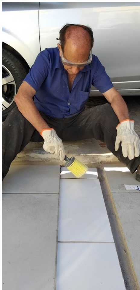
Figura 18 - Aspersão de água nas juntas de assentamento.
