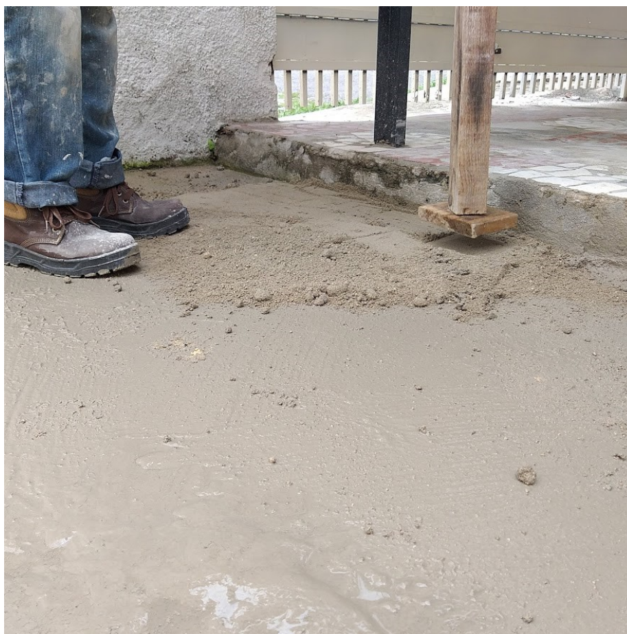
Figura 09 - Apiloamento manual do contrapiso
