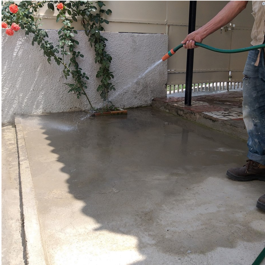
Figura 05 - Limpeza da superfície com água e o auxílio de uma mangueira
