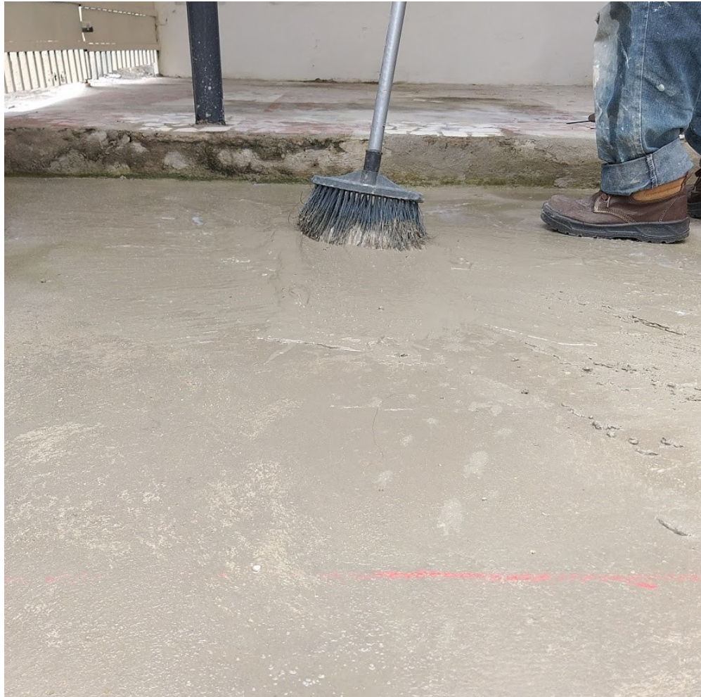
Figura 07 - Caldeamento do contrapiso
