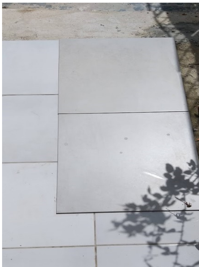
Figura 21 - Sobreposição do piso.
