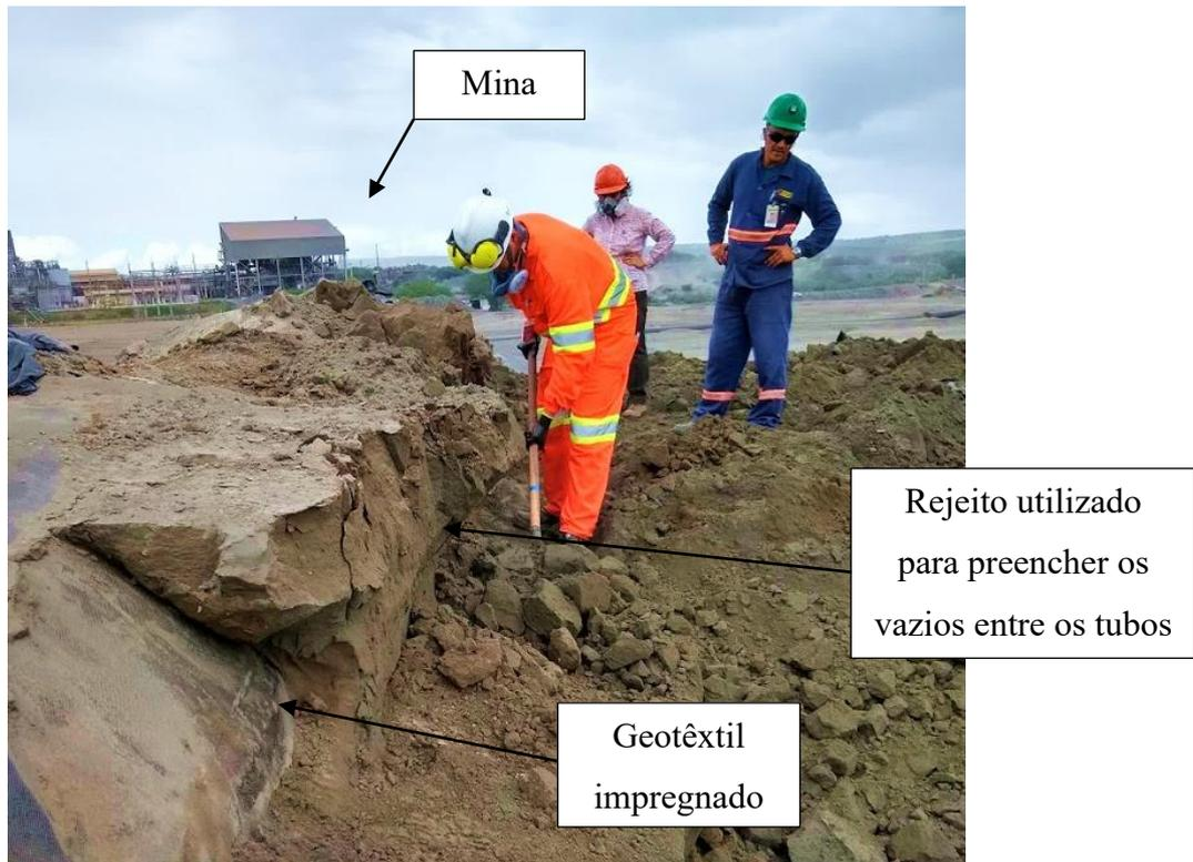
Figura 4-11: Condições do rejeito utilizado para preencher os vazios entre os tubos geotêxteis durante o empilhamento.
