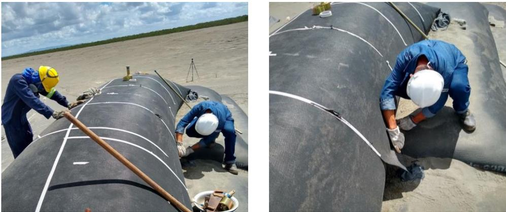
Figura 4-18: Retirada de amostras geotêxteis expostas à radiação UV.
