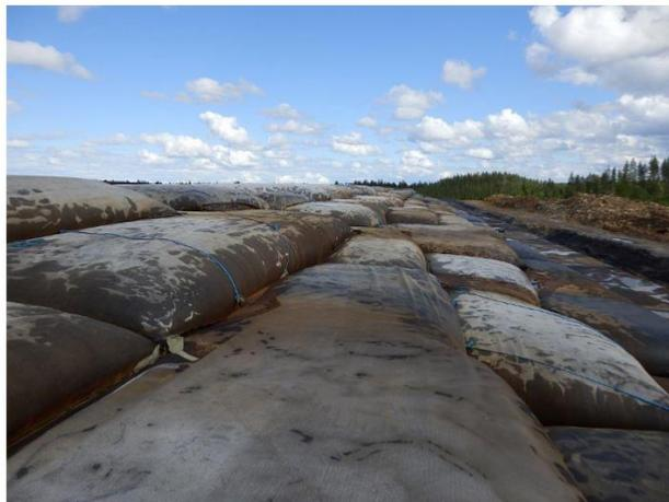
Figura 2-22: Empilhamento de formas têxteis tubulares preenchidas com rejeito de mineração na mina de Talvivaara, Finlândia (Wilke *et al.* 2015)
