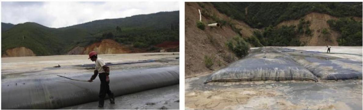
Figura 2-23: Tubos geotêxteis preenchidos para alteamento de barragem (Yang *et al.*, 2019).
