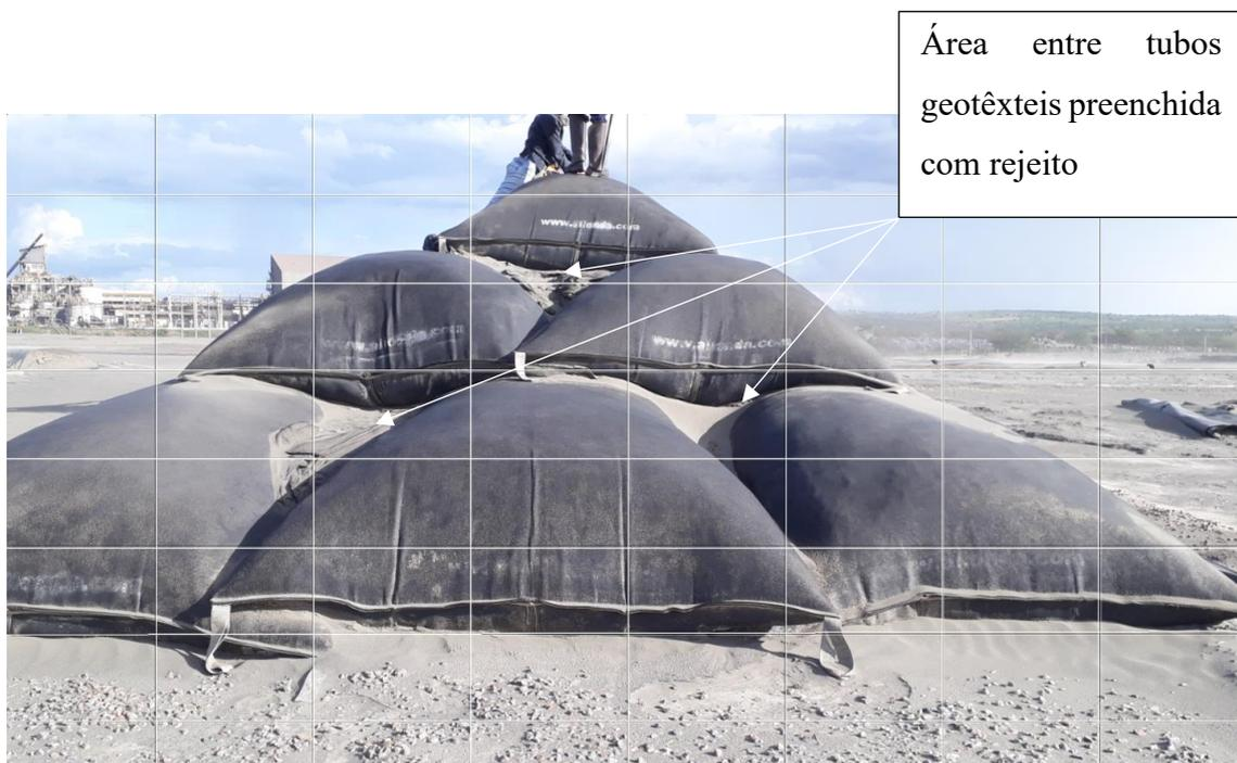
Figura 5-6: Seção transversal da estrutura de tubos geotêxteis.
