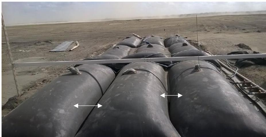
Figura 3-6: Final do enchimento dos tubos geotêxteis da base do empilhamento (Freitas Silva, 2017).
