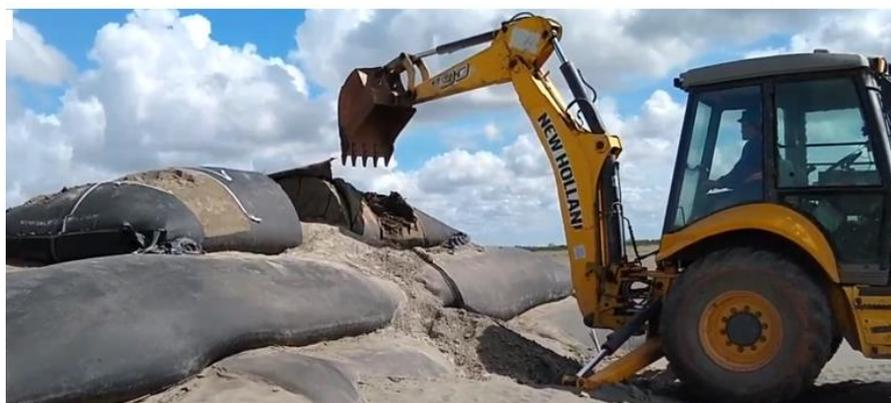
Figura 4-8: Desmontagem do empilhamento com auxílio da retroescavadeira para retirada do TG 14.
