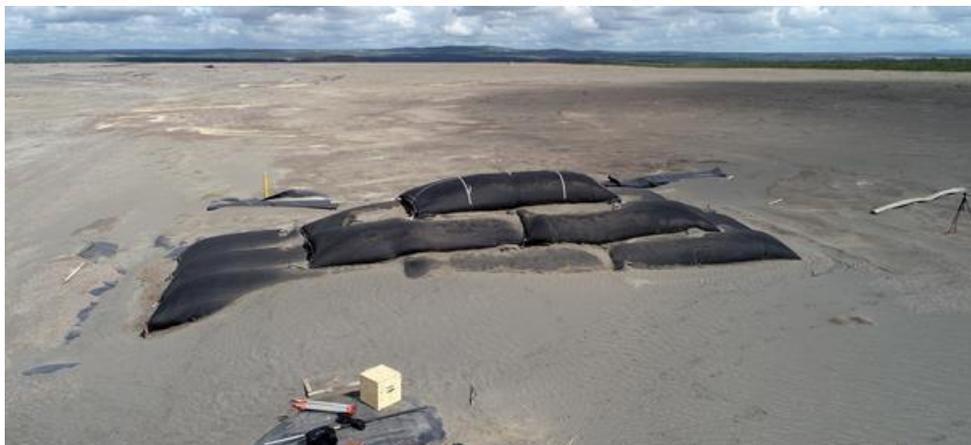
Figura 3-2: Fotografia aérea do empilhamento de tubos geotêxteis – abril/2019.
