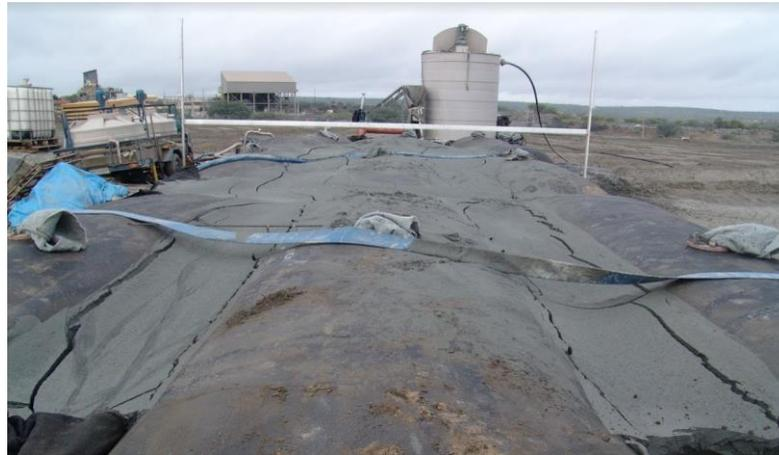
Figura 3-7: Espaço entre os TG da base do empilhamento preenchidos com rejeito de ouro
