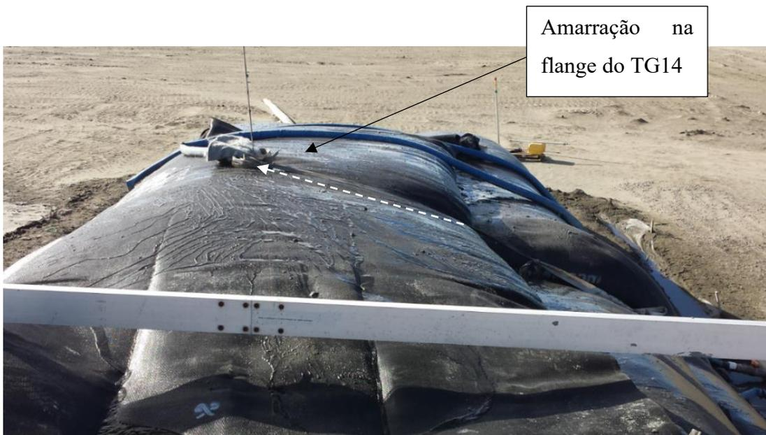
Figura 3-13: Detalhe da amarração realizada na flange do TG14.
