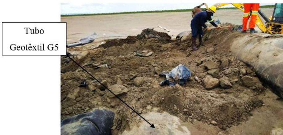
Figura 4-12: Processo de desmontagem do empilhamento para acesso ao tubo geotêxtil TG5.
