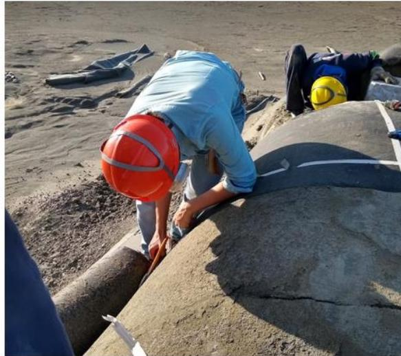
Figura 4-4: Trincas no rejeito confinado na lateral direita do tubo TG14.
