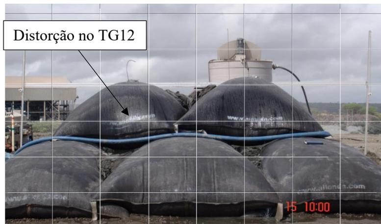
Figura 3-8: Procedimento de construção do empilhamento drenado.
