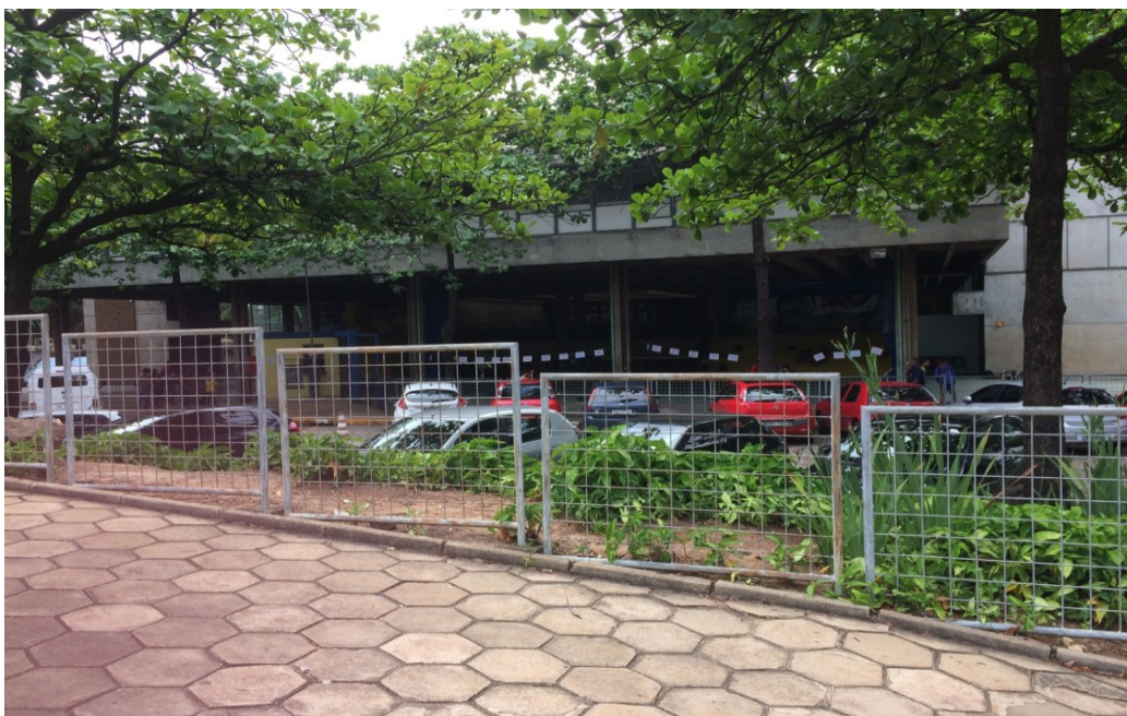
Figura 12 – Foto externa da escola Centro Pedagógico.
