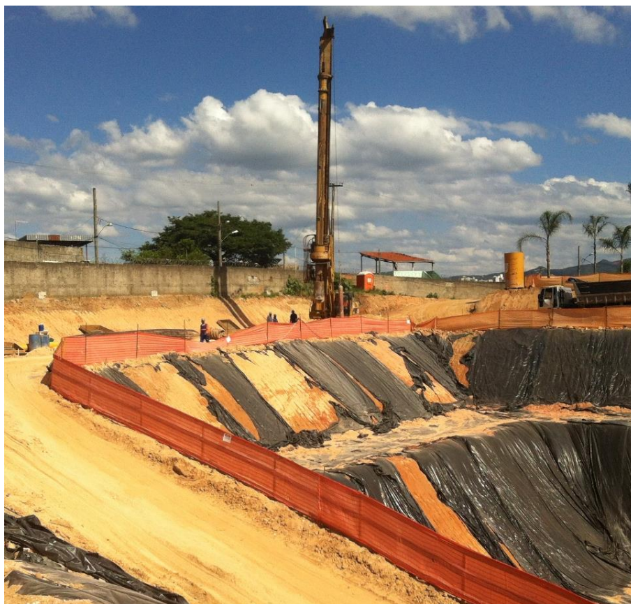
Figura 3.23 - Execução das Estacas da contenção (LOCALIZA, 2015)
