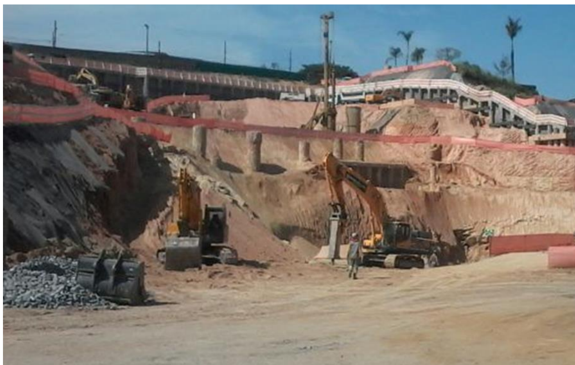
Figura 3.4 - Foto da obra em uma elevação próxima a El.840 m.
