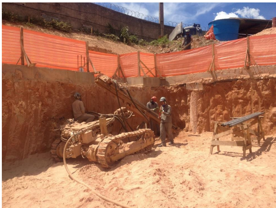
Figura 3.24 - Execução da primeira linha de tirante contenção Máquina perfuratriz dos tirantes (LOCALIZA, 2015)
