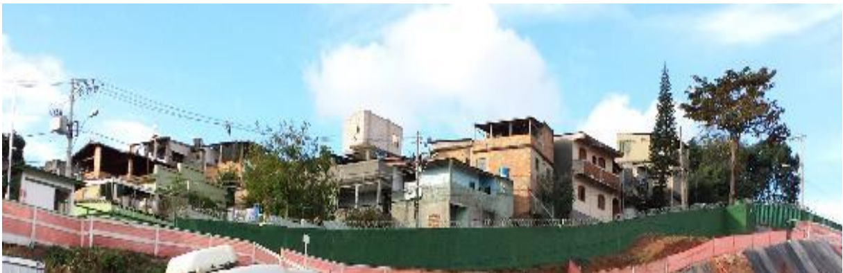
Figura 5.9 - Foto das casas localizadas acima da contenção
