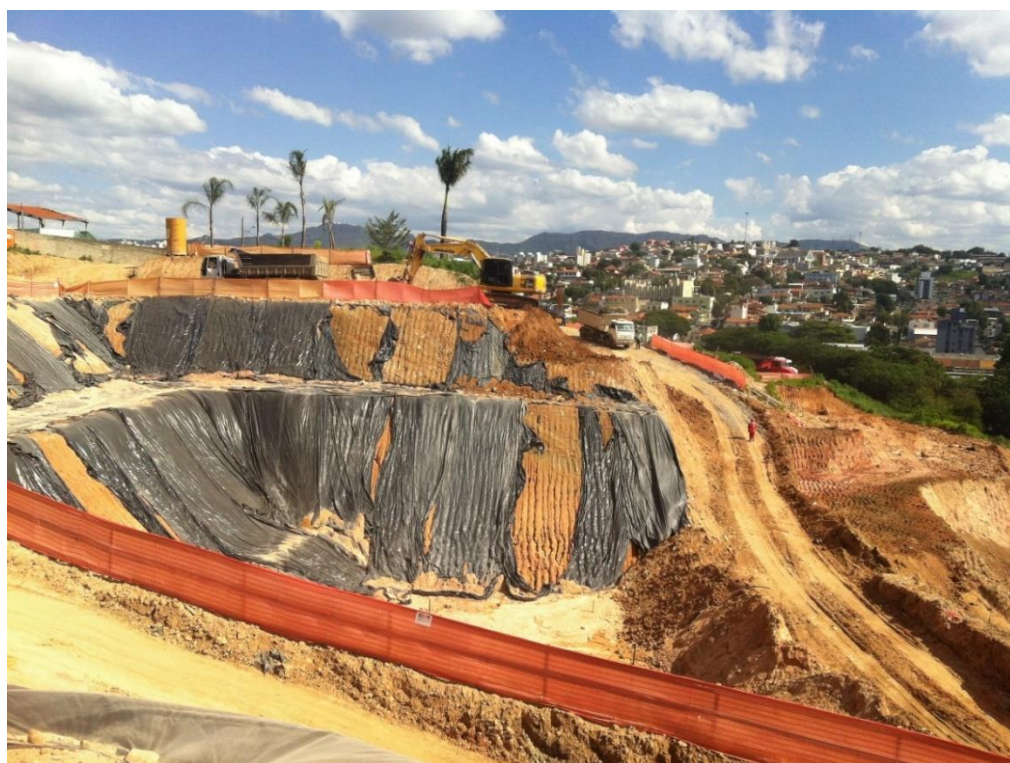
Figura 3.22 - Escavações do acesso (LOCALIZA, 2015)
