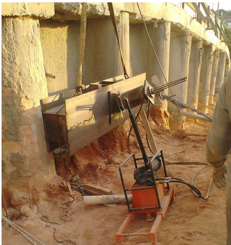
Figura 3.25 - Colocação da viga metálica de travamento dos tirantes (LOCALIZA, 2015)
