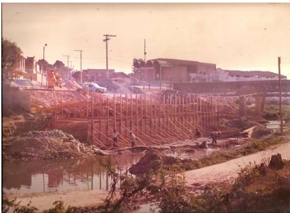
Figura 13 – Obras da Ponte do Rio Betim entre Rua Dr. Gravatá e Rua do Rosário, 1980.
