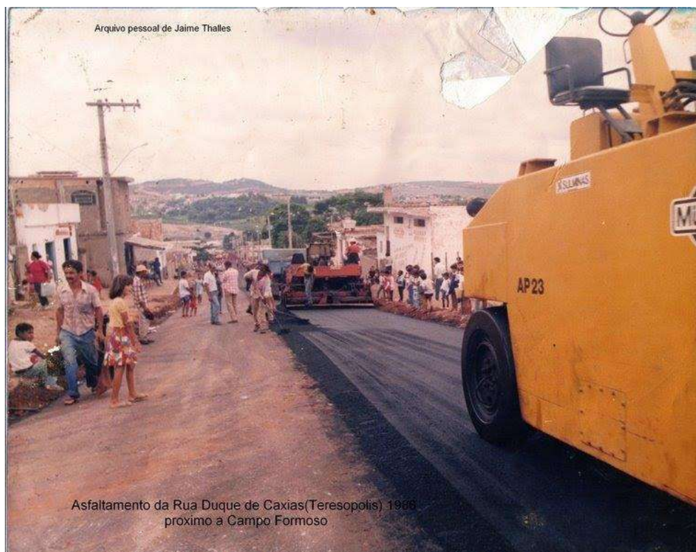
Figura 23 – Asfaltamento da Rua Duque de Caxias, Jardim Teresópolis, 1986.
