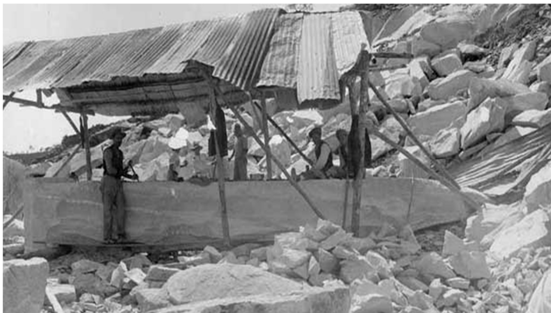
Figura 3 – Pirulito da Praça 7 sendo esculpido em Betim, às margens do Rio Betim.
