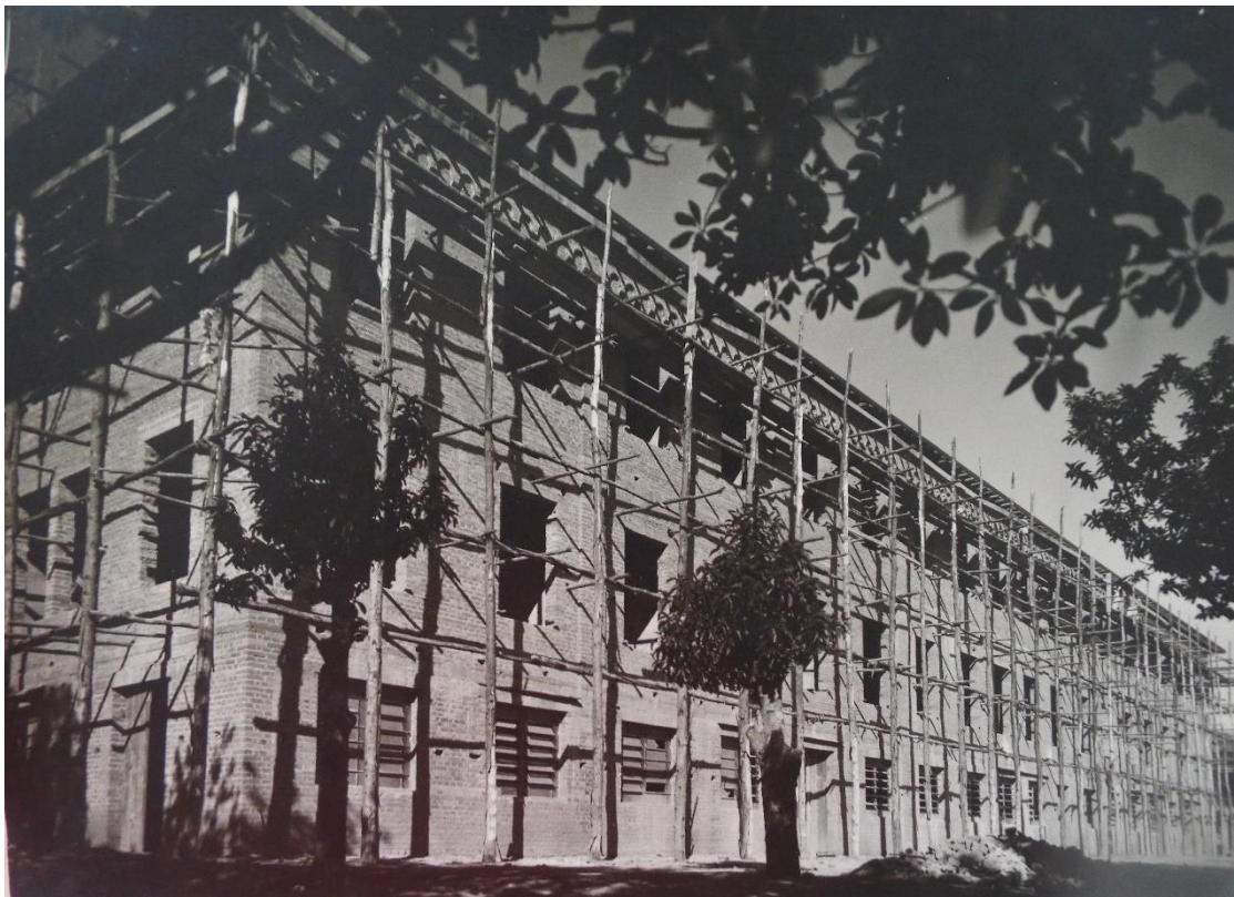
Figura 21 – Vista interna da construção novas instalações do Colégio São João, no início dos anos 1940.
