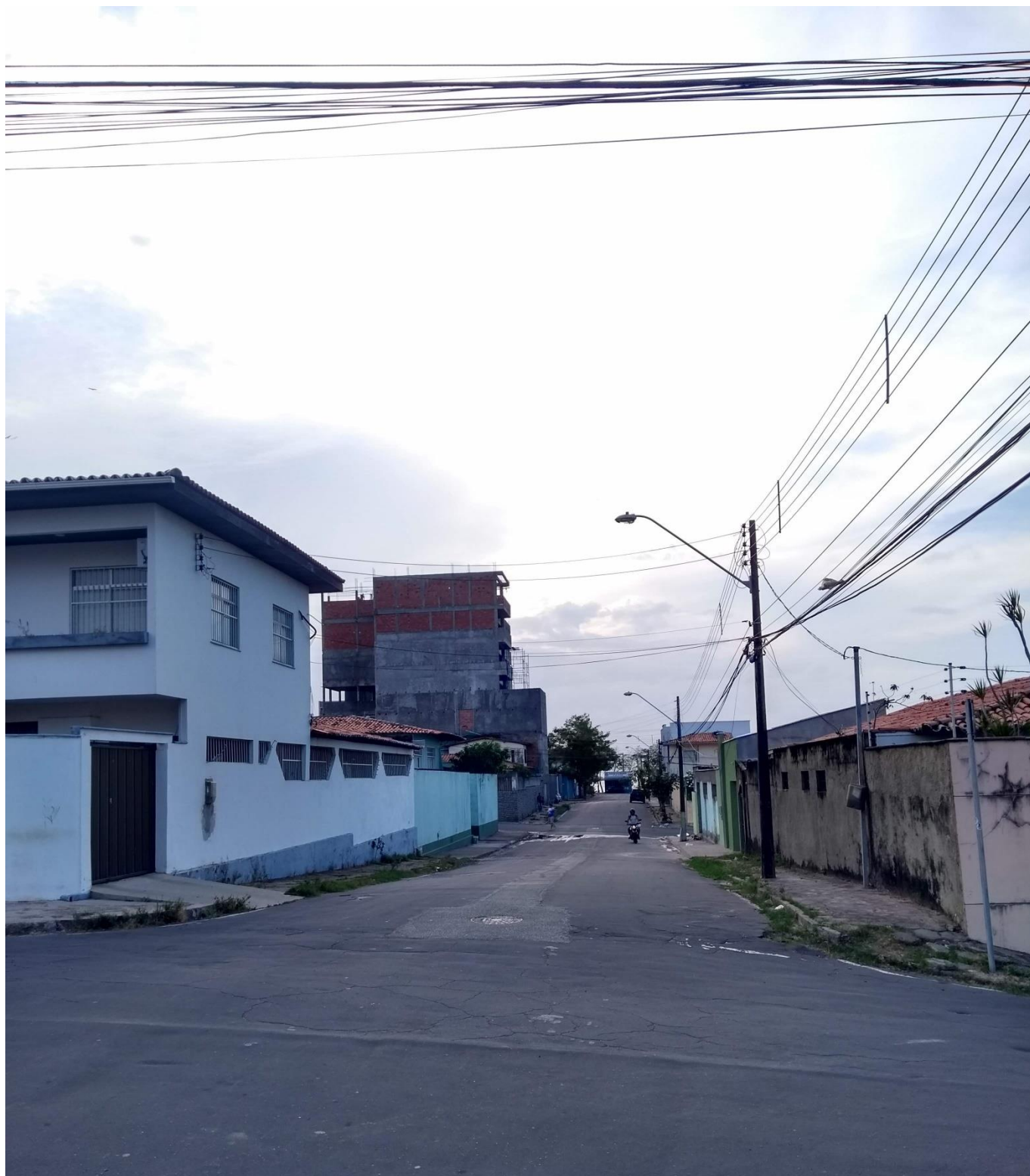
Figura 38: Rua Coronel Chaves em um dia de semana, por volta das 17 horas. A edificação em construção é um futuro prédio de escritórios de uma empresa que já possui um edifício no bairro, em frente à praça Botafogo, cuja obra encontra-se parada desde 2019. A pequena edificação azul no final da rua é o posto policial da Praça Botafogo. A foto foi tirada exatamente no meio do caminho entre a Praça da Igreja e a Praça Botafogo. Fonte: Fotografado por mim em 2020.
