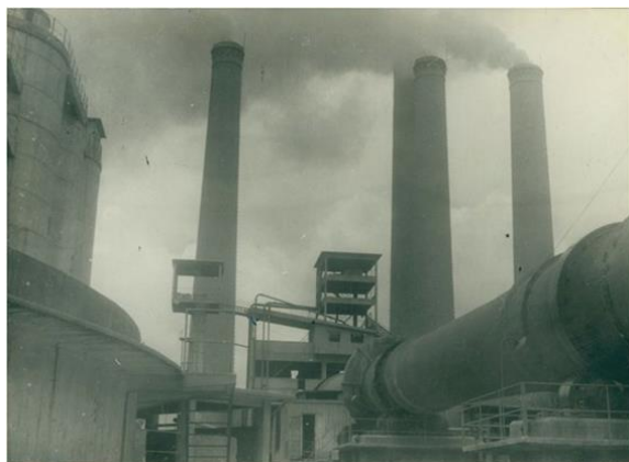
Foto 15 – Antiga Companhia de Cimento Portland Itaú (atual Shopping Itaú), em Contagem
