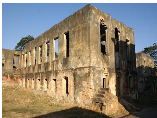
Foto 31 – As ruínas dos antigos pavilhões da Colônia Santa Isabel
