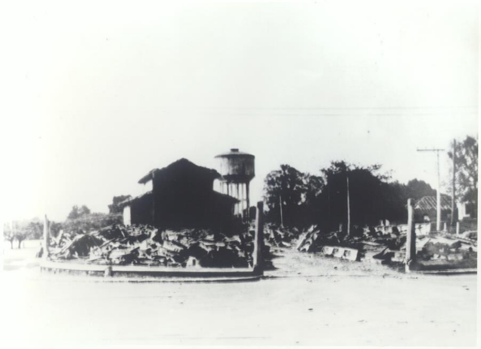
Foto 8 – Igreja Matriz de Nossa Senhora do Monte Carmo (em processo de demolição)
