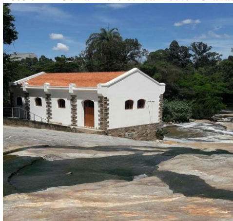
Foto 52 – Usina Hidrelétrica Doutor Gravatá
