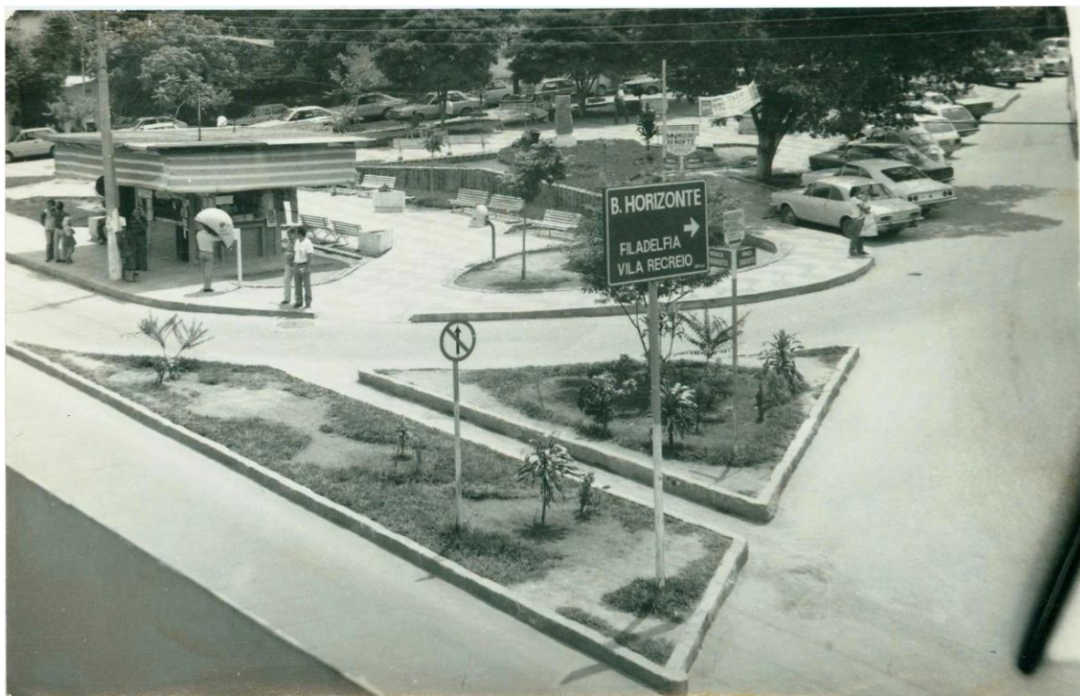
A Praça Tiradentes (Betim) em 1980. Betim, 22 de jun. 2019. Facebook: @bairrojardimteresópolis. Disponível em: < https://www.facebook.com/bairrojardimteresopolis/posts/2546466088705902/ >. Acesso em: 02 jan. 2021.
