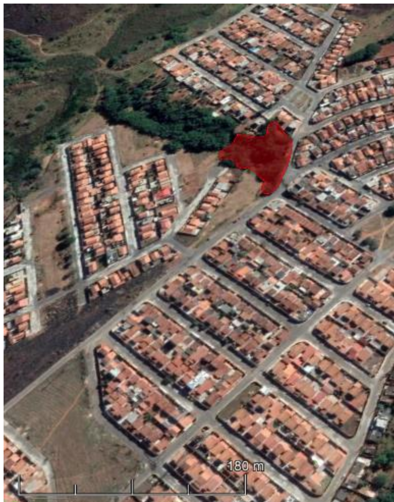
Figura 23 - Área Aterro irregular 6.
