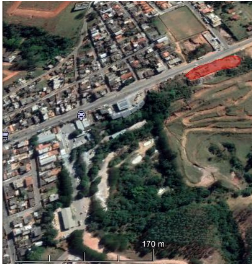
Figura 25 - Área Aterro irregular 7.
