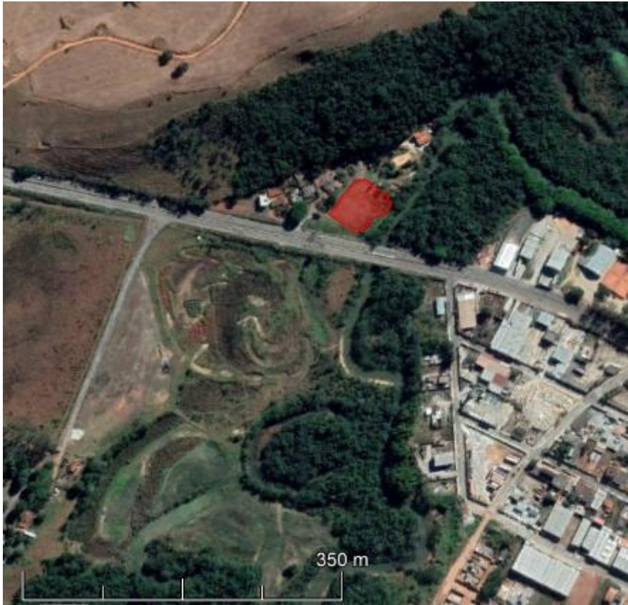
Figura 16 - Área Aterro irregular 3.
