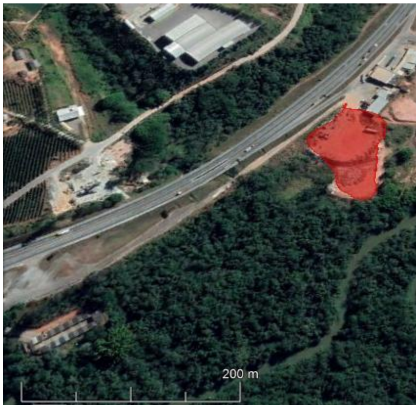
Figura 21 - Área Aterro irregular 5.
