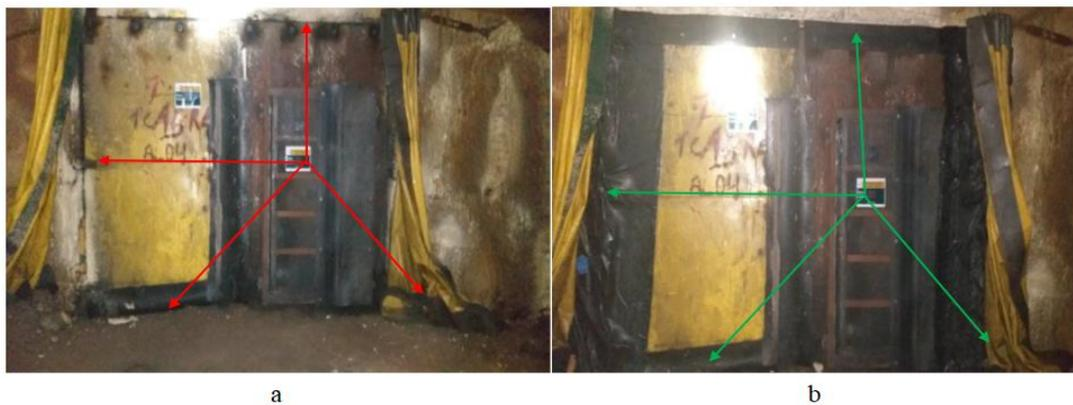
Figura 3.45- (a) perdas de ar entre portas; (b) aplicação de vedação em portas de acessos para redução de fugas de ar. (Contribuição do autor, 2020).
