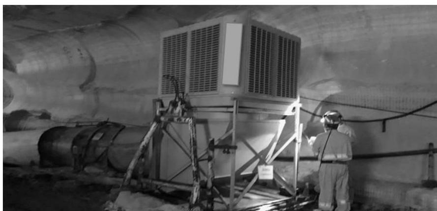
Figura 3.51- Instalação do climatizador acoplado ao ventilador secundário.
