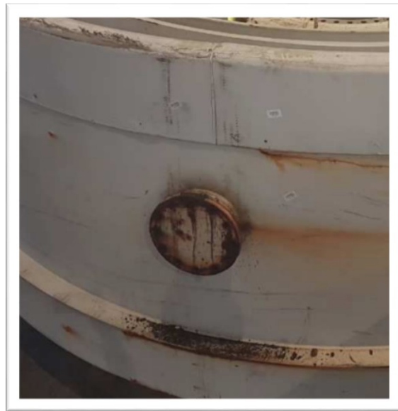
Figura 48 - Exemplo de oxidação acentuada em alguns pontos (fonte: Empresa proprietária do parque)
