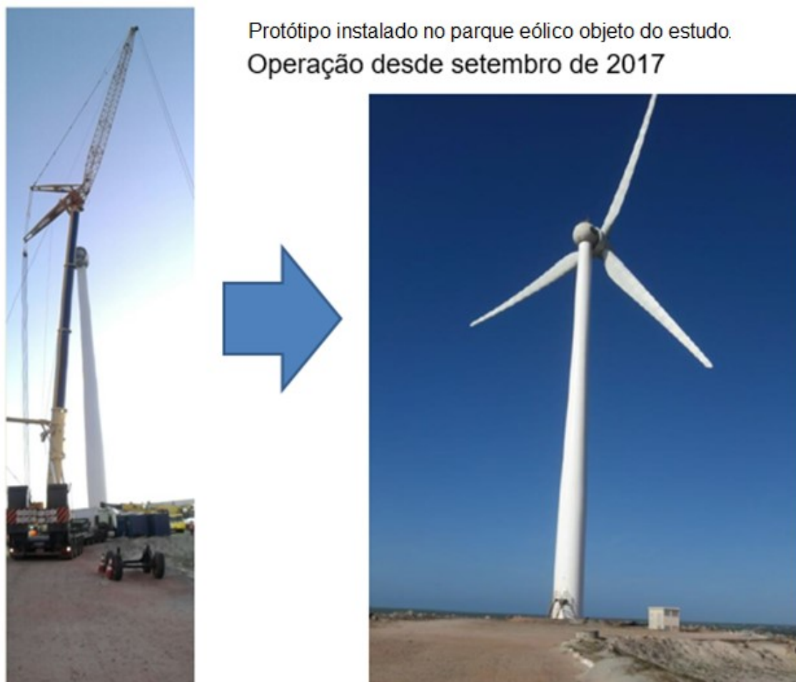
Figura 57 - Protótipo recuperado e instalado em Set/2017 - Aerogerador nº05 (Fonte: Empresa proprietária do parque)
