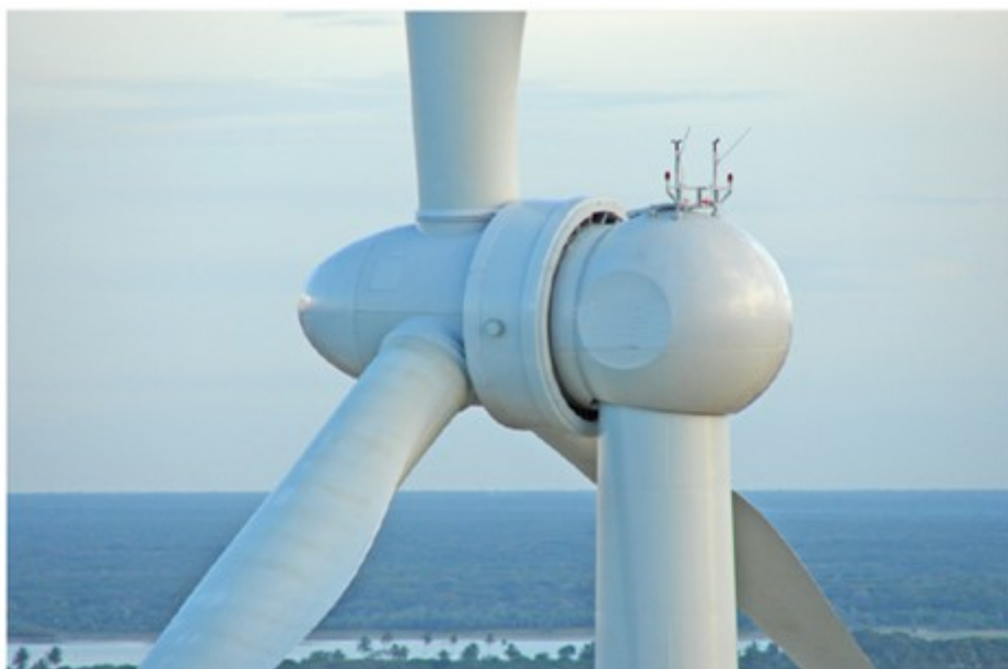
Figura 22 - Foto do Aerogerador do parque em estudo (Fonte: Descrição técnica do parque em estudo)
