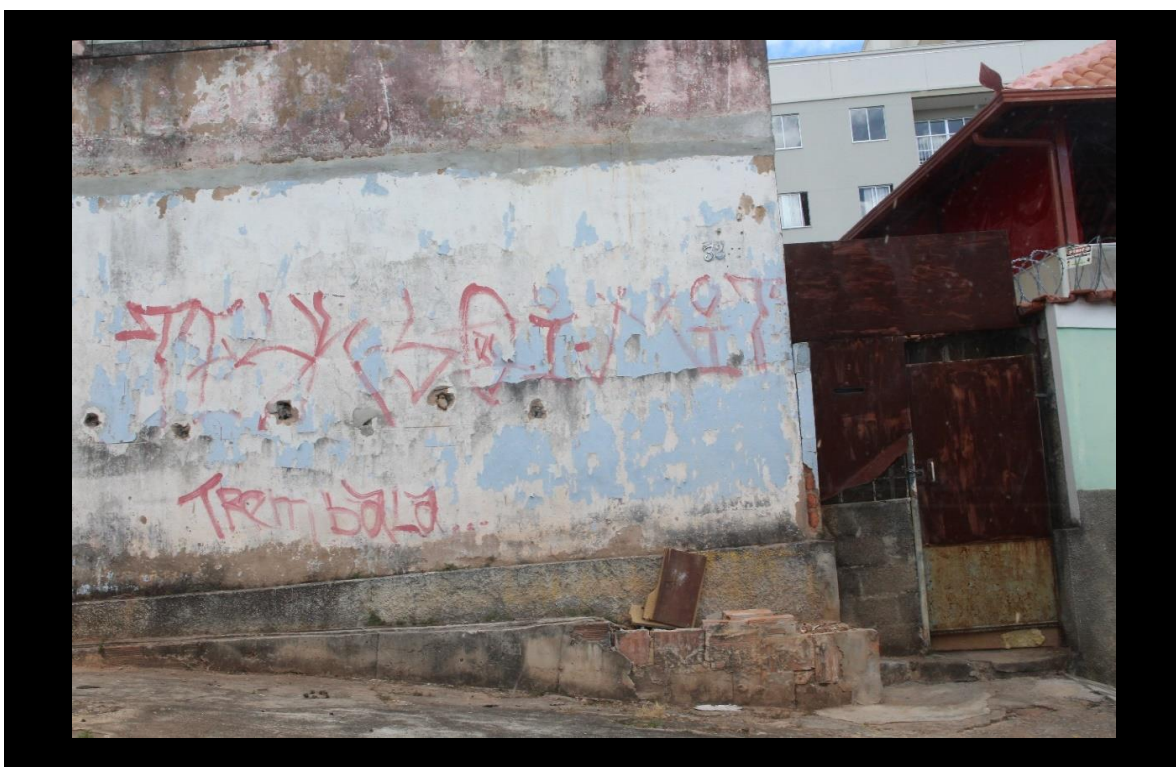
Figura 53 – Área 2 - Jardim Guanabara. Antigas edificações. 2017
