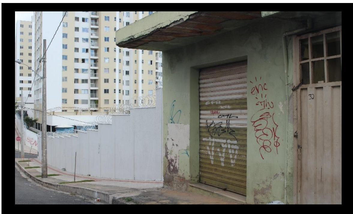
Figura 51 – Área 2 - Jardim Guanabara. Antigas e novas edificações. 2017
