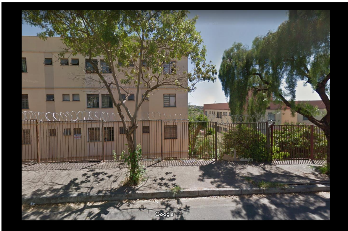
Figura 56 – Área 2 - Jardim Guanabara. Antigas edificações. 2017
