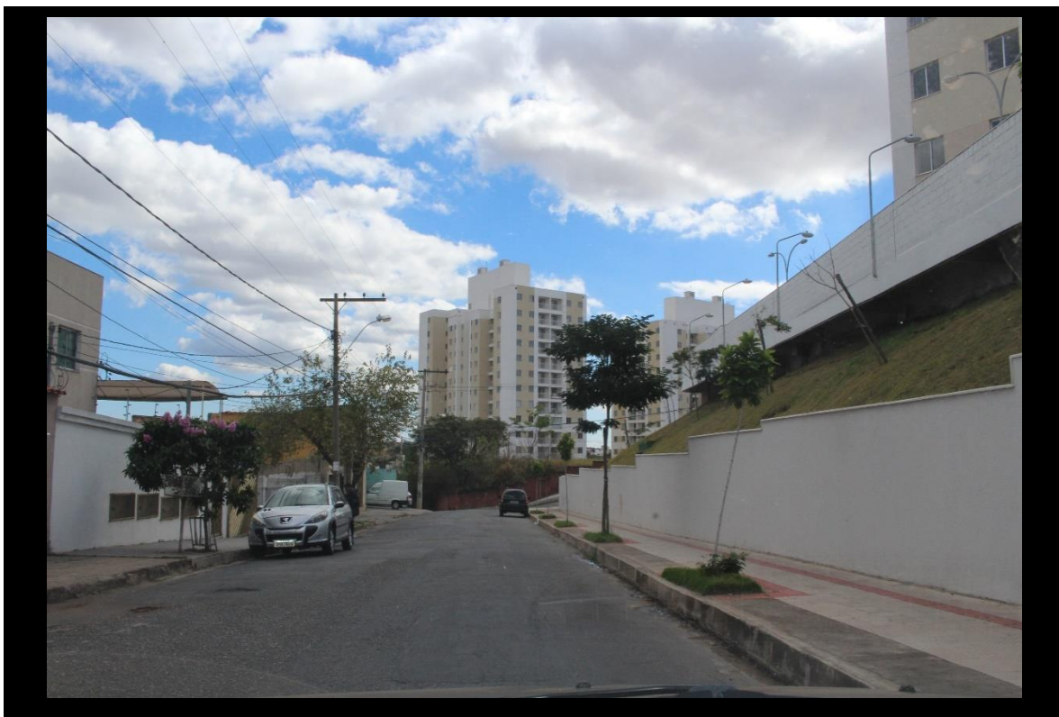
Figura 49 – Área 2 - Jardim Guanabara. Novas Edificações. 2017
