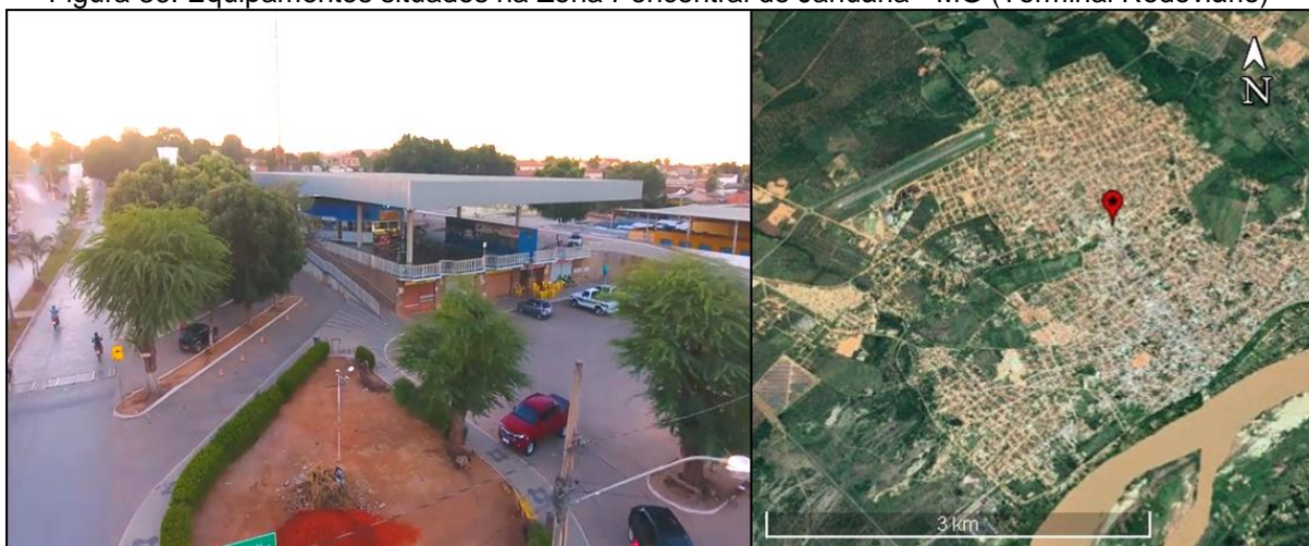
Figura 36: Equipamentos situados na Zona Pericentral de Januária - MG (Terminal Rodoviário)
