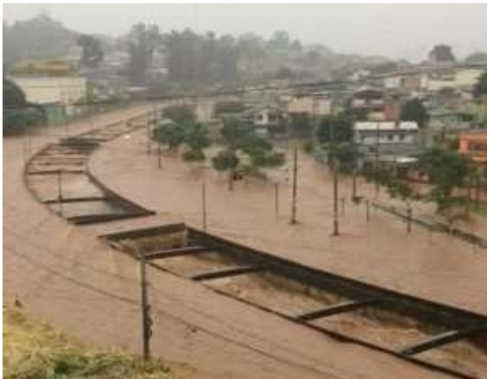
Figura 20 – Alagamento da Av. Tereza Cristina, próximo ao bairro Betânia e Cidade Industrial após temporal do dia 19 de janeiro de 2020
