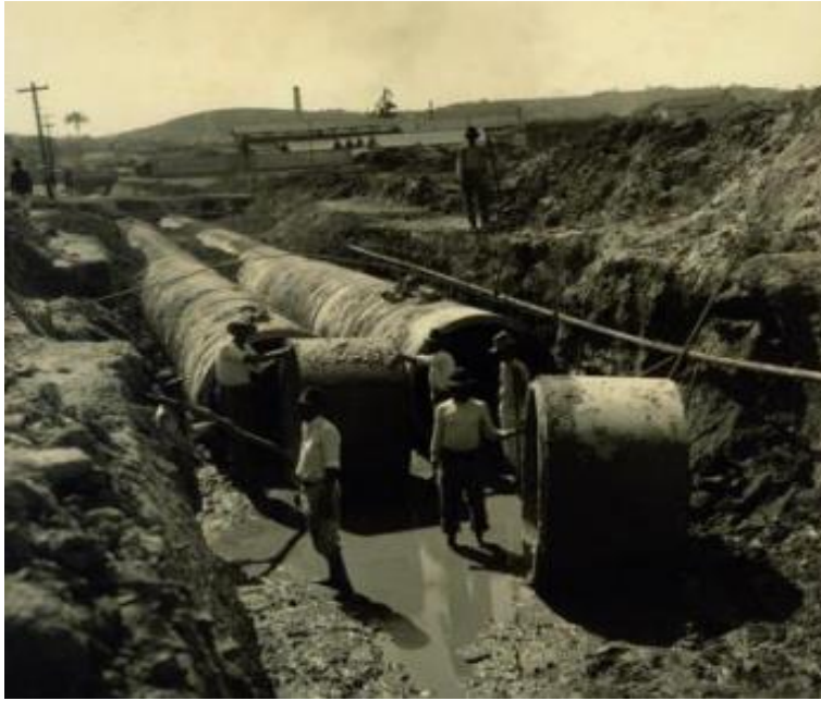
Figura 12 – Assentamento de manilhas de concreto para canalização do córrego da Barroca
