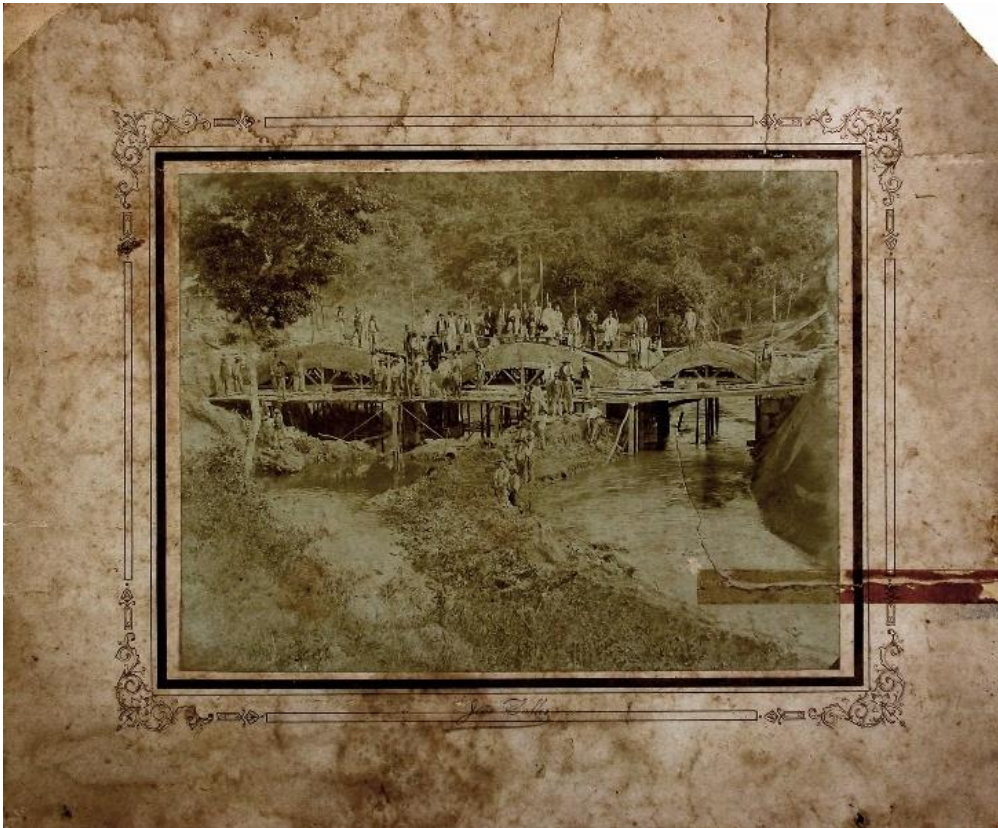
Figura 11 – Trabalhos de tubulação no Ribeirão Arrudas, em 1896
