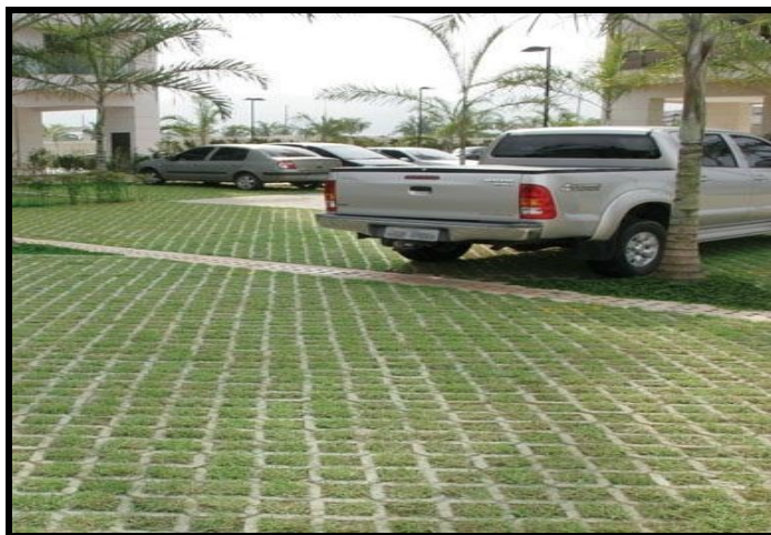
Figura 13 – Implantação de estacionamentos drenantes
