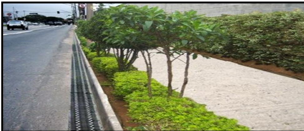
Figura 12.1 – Implantação de calçadas drenantes
