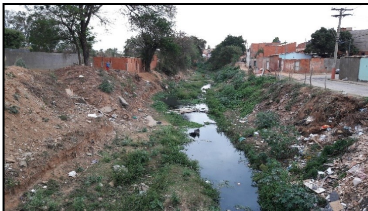
Figura 9 – Córrego do Cintra – Ponte da Av. Minas Gerais – Alto Floresta
