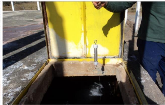
Caixa D'água da Mina (ID-54)
