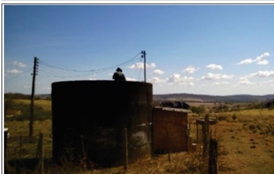
Poço Fz. Sto Antônio Cerca Grande PT2 (ID-16)
