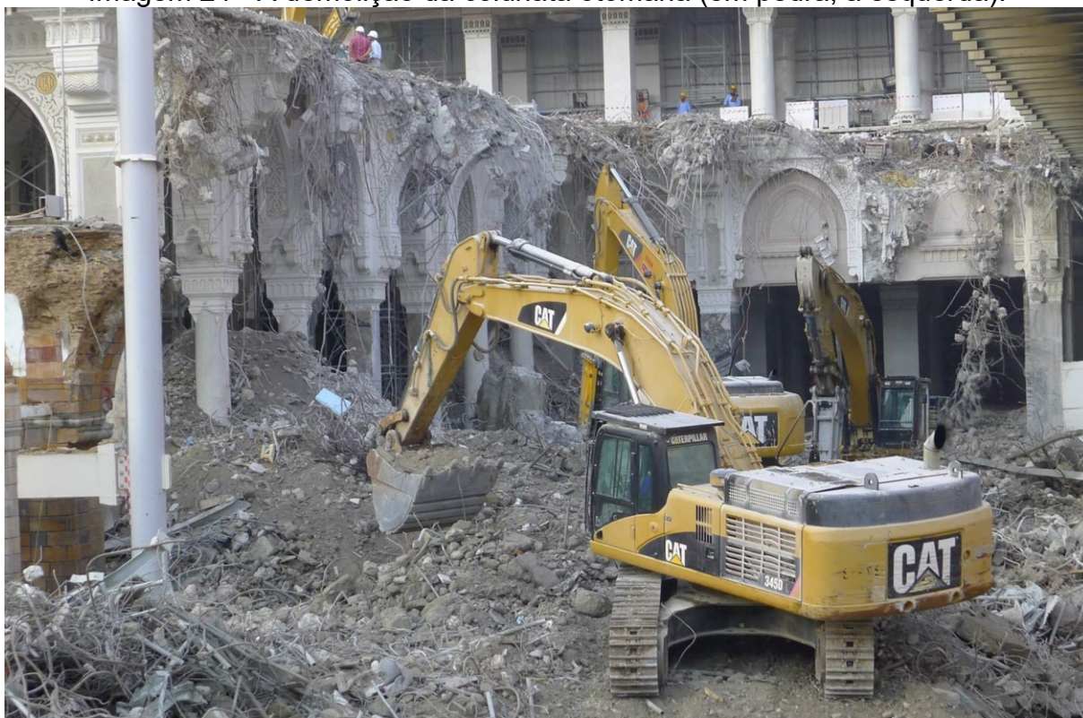
Imagem 24 - A demolição da colunata otomana (em pedra, à esquerda).
