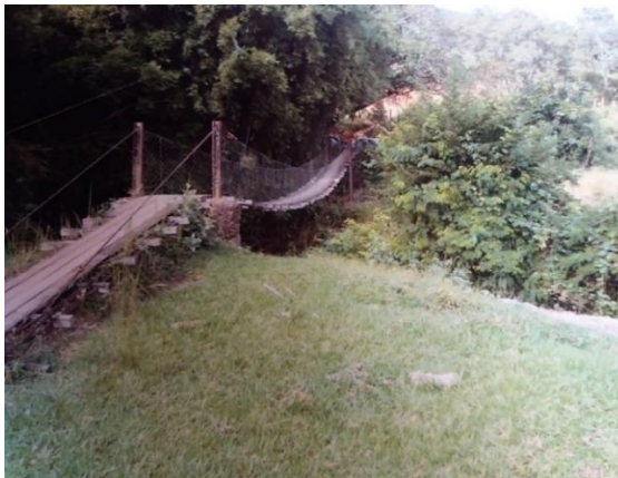
Figura 23 - Travessia em propriedade em Pedras antes da passagem da lama
