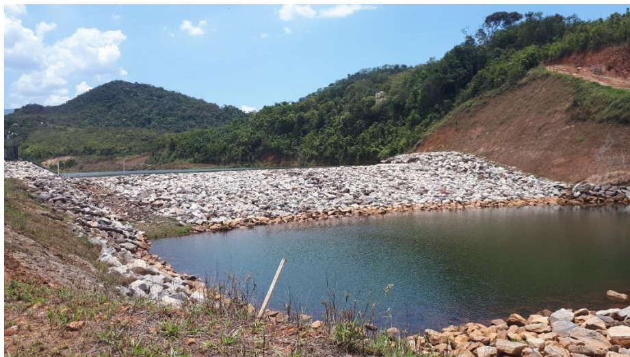
Figura 7 - Dique S4 a jusante do barramento - córrego Santarém, subdistrito de Bento Rodrigues
