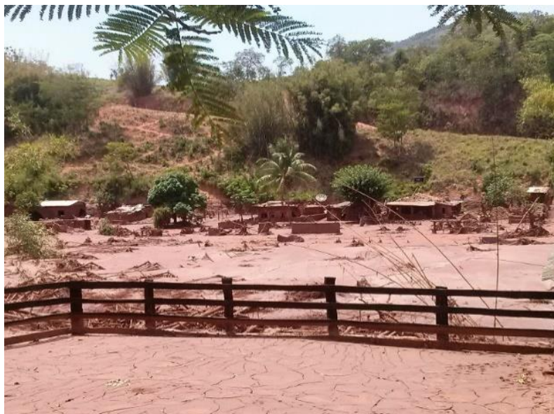
Figura 33 - Residências em Gesteira, após a passagem da lama
