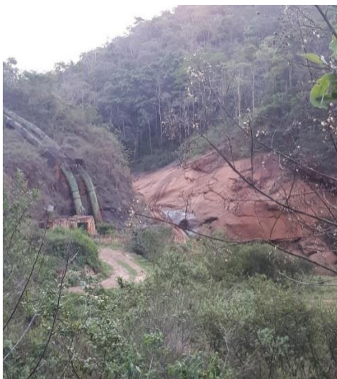
Figura 11 - Vista de baixo da PCH Bicas
