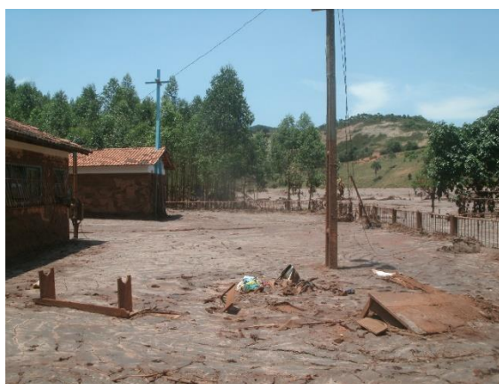
Figura 14 - Centro comunitário de Ponte do Gama após a deposição de rejeitos (Dez/2015)
