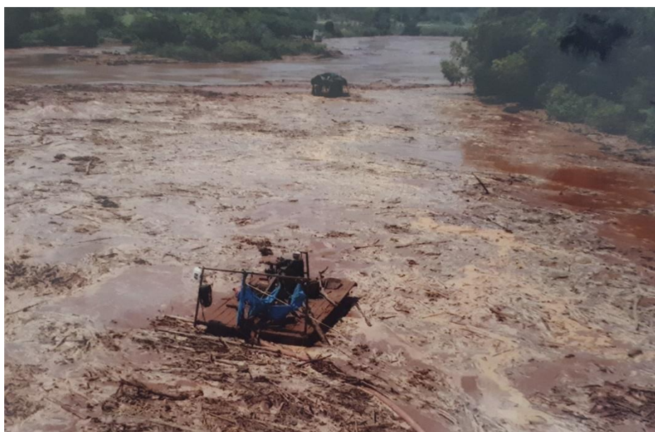
Figura 49 - Areal após a passagem da lama
