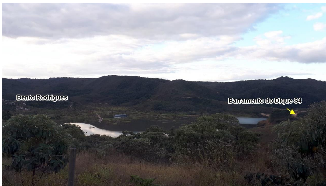
Figura 8 - Dique S4 a montante do barramento – córrego Santarém, subdistrito de Bento Rodrigues
