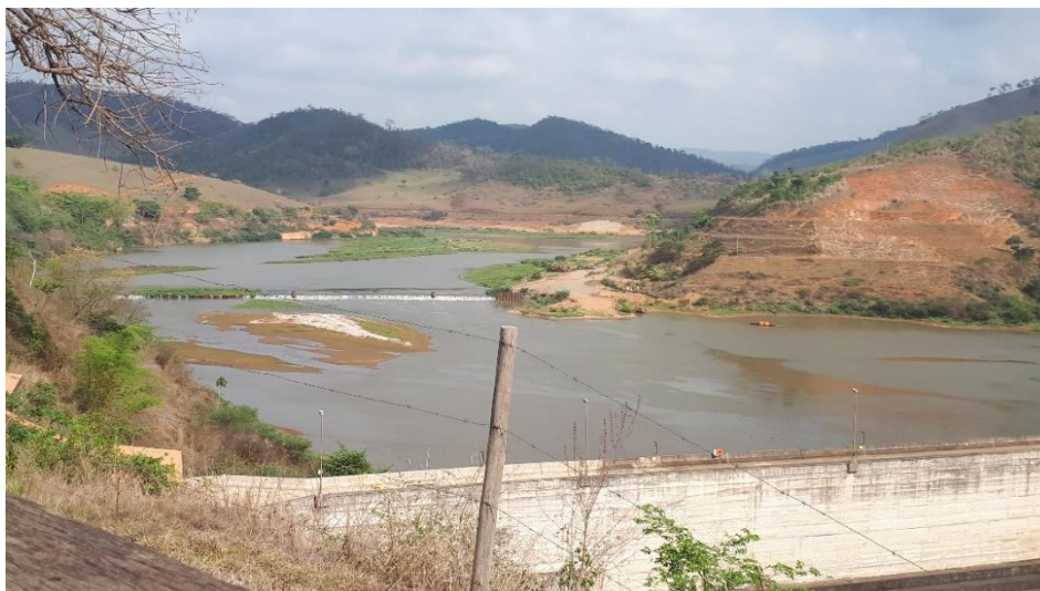
Figura 45 - Vista do reservatório da UHE Risoleta Neves, a montante do barramento
