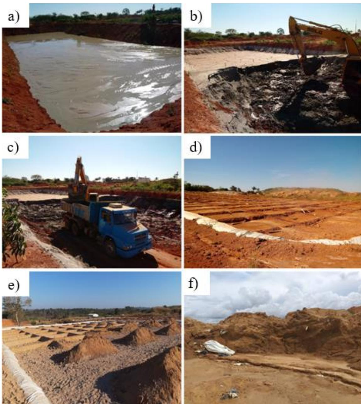
Figura 4.2: a) Barragem de rejeito b) Remoção dos rejeitos da barragem para alimentação da lixiviação c) Carregamento e transporte do rejeito d) Material para a lixiviação e) Material cianetado f) Material estudado - rejeito da cianetação.
