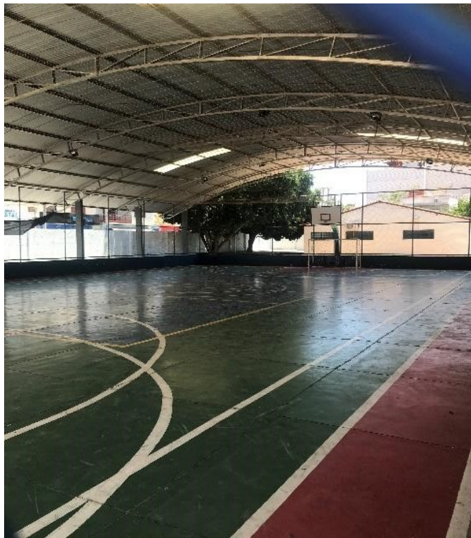
Figura 21: Quadra poliesportiva coberta
