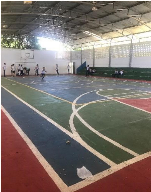
Figura 28: Quadra poliesportiva coberta
