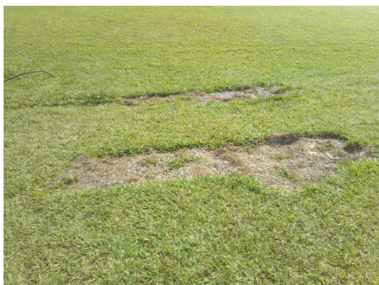
(a) Exemplo de cavidade no terreno.
