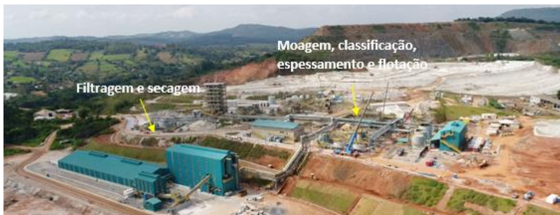
Figura 3.10. Usina de beneficiamento de espodumênio da AMG.
