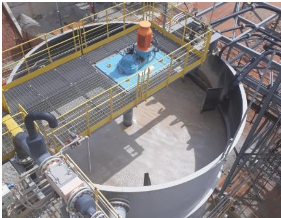
Figura 3.12. Tanque de regularização.
