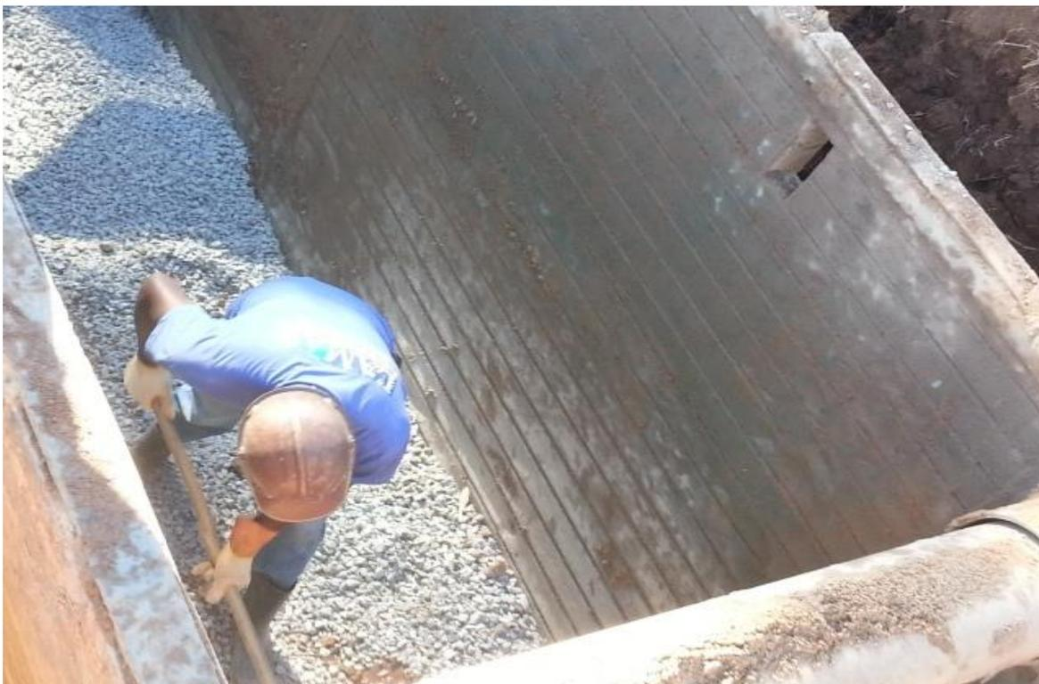
**Figura 3:** Execução de dreno com material granular dn 0,01 m.
