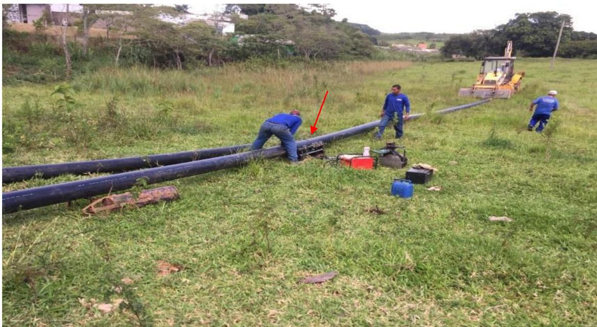
**Figura 1:** Soldagem do tubo PEAD por extrusão.
