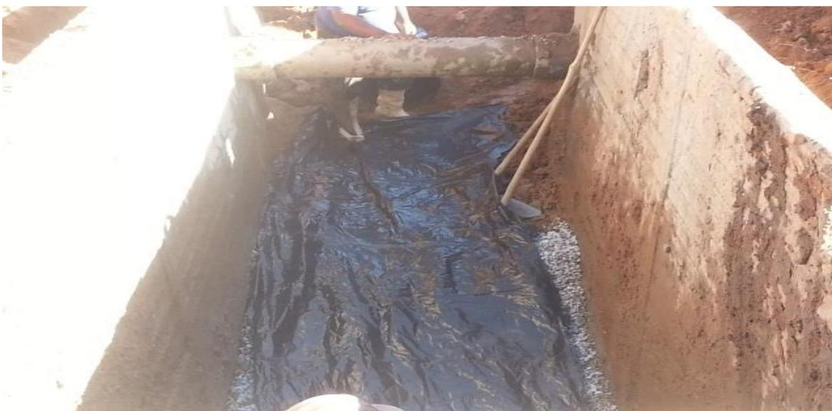
**Figura 4:** Aplicação de lona para impermeabilização de vala.
