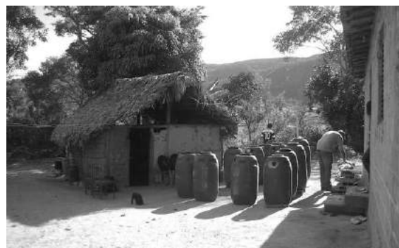
Figura 3: Tambores para as fossas sépticas, entre a cozinha de pau-a-pique e a casa de blocos de concreto.
