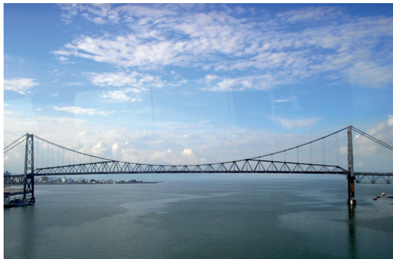
Figura 1 – Vão central pênsil da Ponte Hercílio Luz, com 339,5 m de comprimento.
