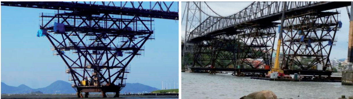
Figura 12 – Montagem das torres da estrutura auxiliar.
