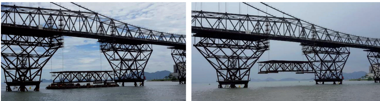
Figura 13 – Montagem das treliças intermediárias da estrutura auxiliar.
