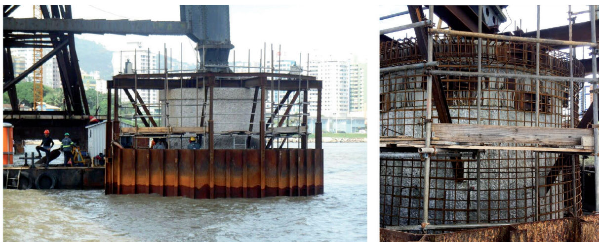
Figura 15 – Instalação das ensecadeiras e procedimento de reforço das fundações.
