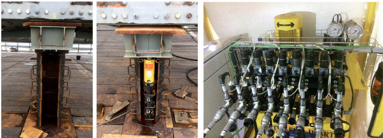
Figura 15 – Calços metálicos, macacos e unidade hidráulica utilizados na transferência de cargas.
