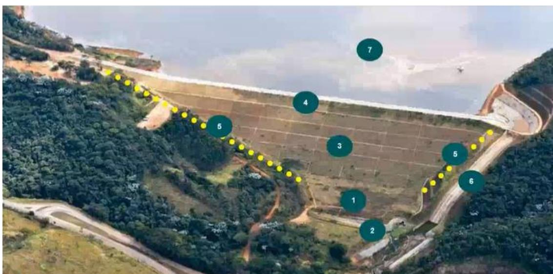
Elementos de uma barragem: 1 - fundação; 2 - drenagem interna; 3 - aterro/maciço; 4 - crista; 5 - ombreiras; 6 - vertedouro ou extravasor; 7 - reservatório (VALE, 2020).
