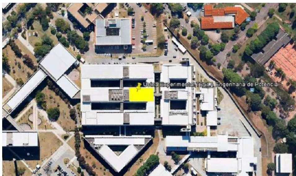
Figura 37 – Local da instalação da Usina Experimental Fotovoltaica TESLA Engenharia de Potência.
