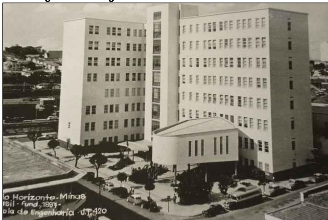
Figura 54 - Antiga EEUFMG - Edifício Arthur Guimarães
