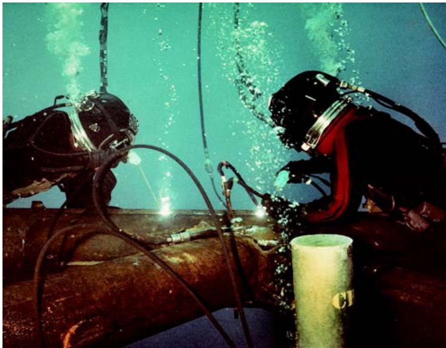
Figura 2.2 - Técnica de soldagem subaquática molhada Fonte: Welding Handbook, Volume IV (2011)
