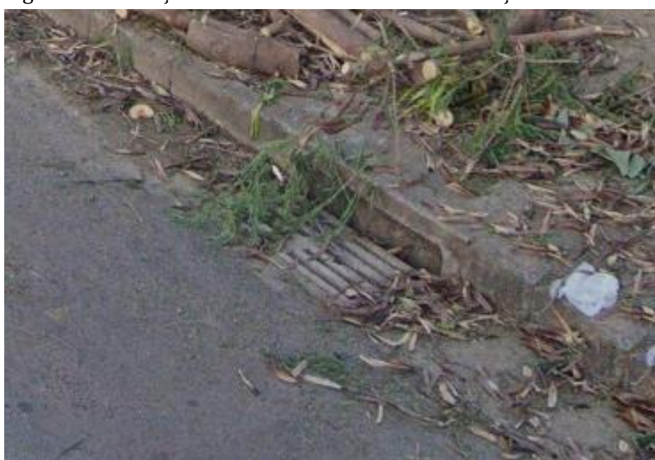
Figura 20 - Situação dos bueiros na área de intervenção
