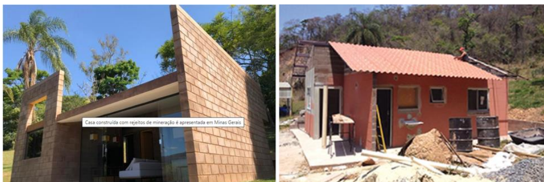
FIGURA 5. Modelos de casas usando rejeitos de minério de ferro em projetos de colaboração entre a UFMG/Samarco/Gerdau (FAPESP, 2019; JN, 2020).
