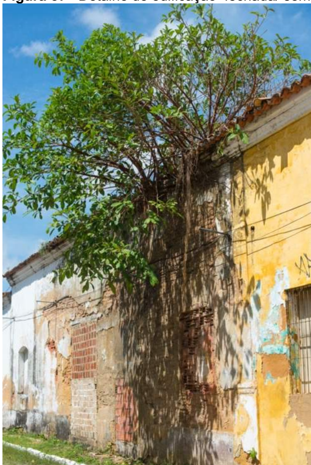
Figura 57 – Detalhe de edificação fechada/ sem uso na Rua do Comércio
