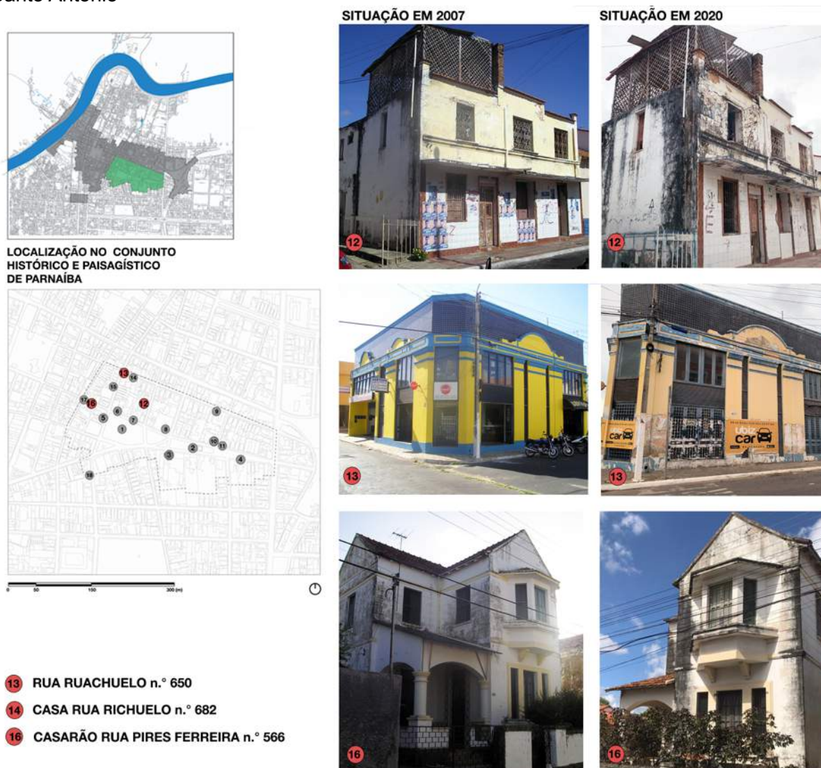
Figura 109 – Diagnóstico comparativo do estado de conservação - edificações conj. Praça Santo Antônio
