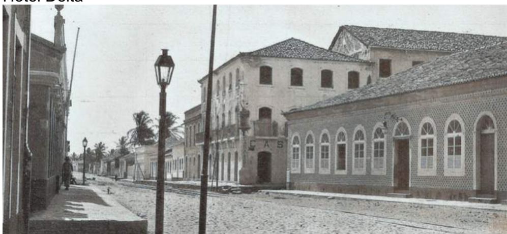
Figura 152 – Edifício com características coloniais no local onde hoje se encontra o Hotel Delta
