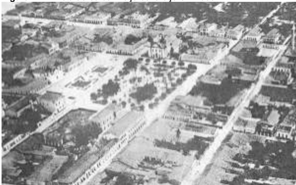
Figura 117 – Vista aérea da Praça da Graça em 1935
