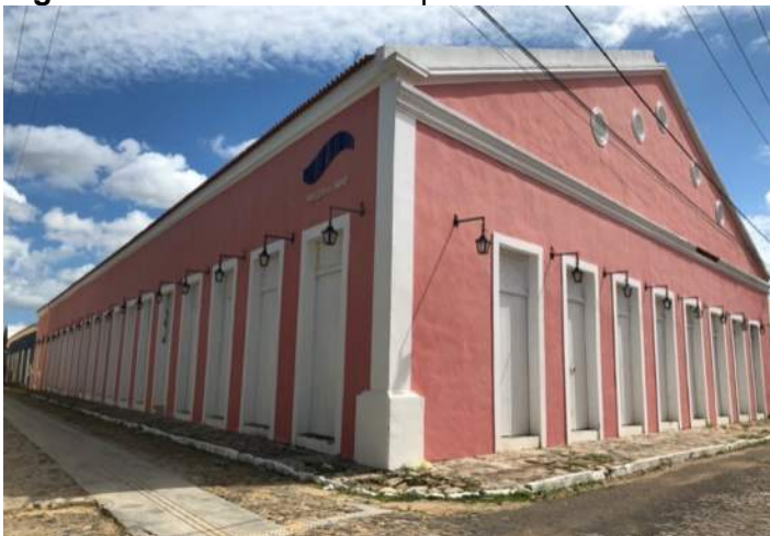
Figura 64- Reforma do Complexo Cultural Porto das Barcas
