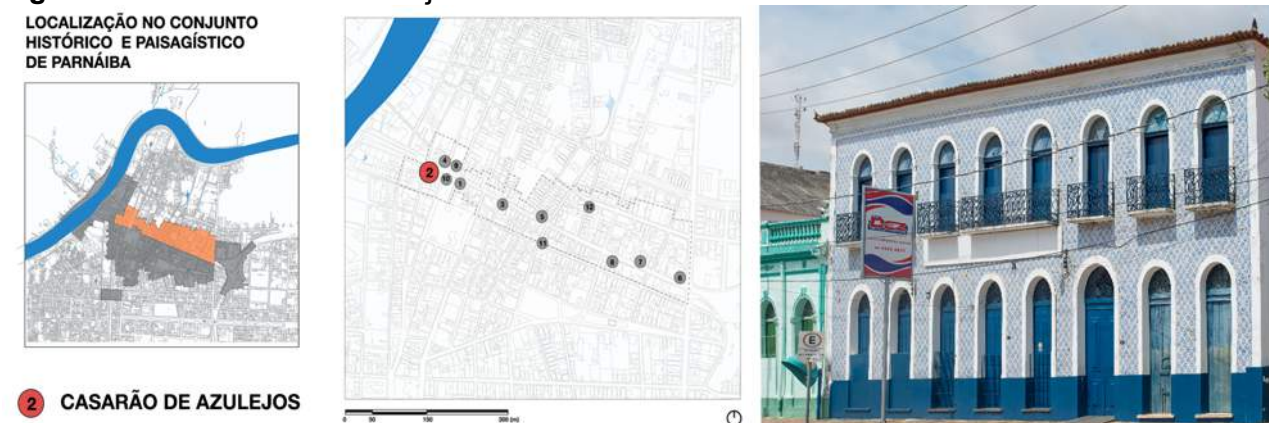
Figura 145– Casarão de Azulejos
