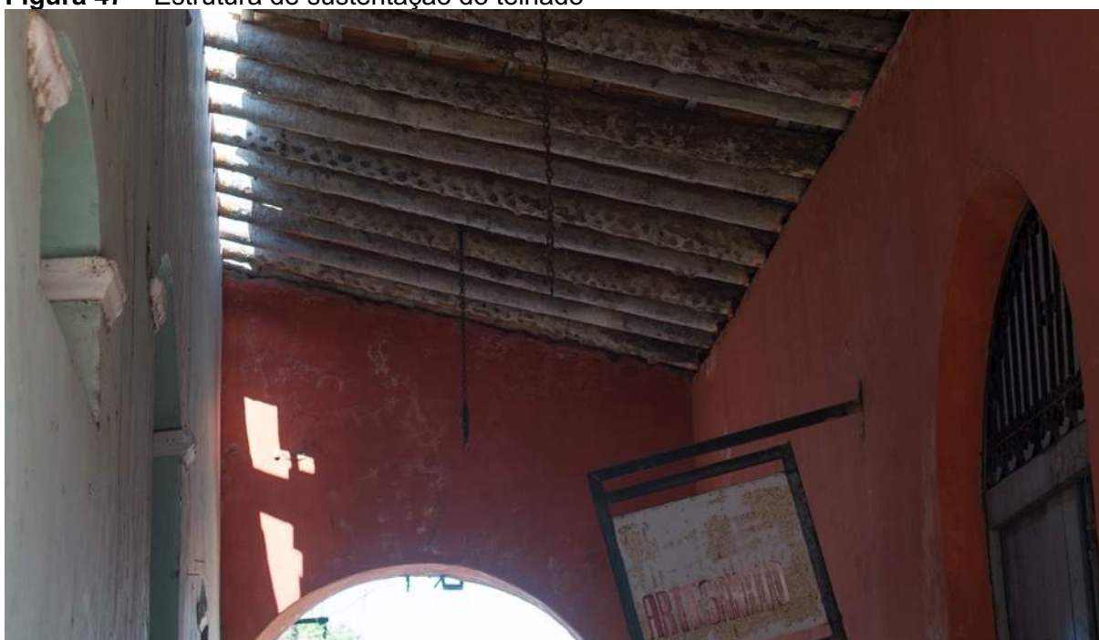
Figura 47 – Estrutura de sustentação do telhado
