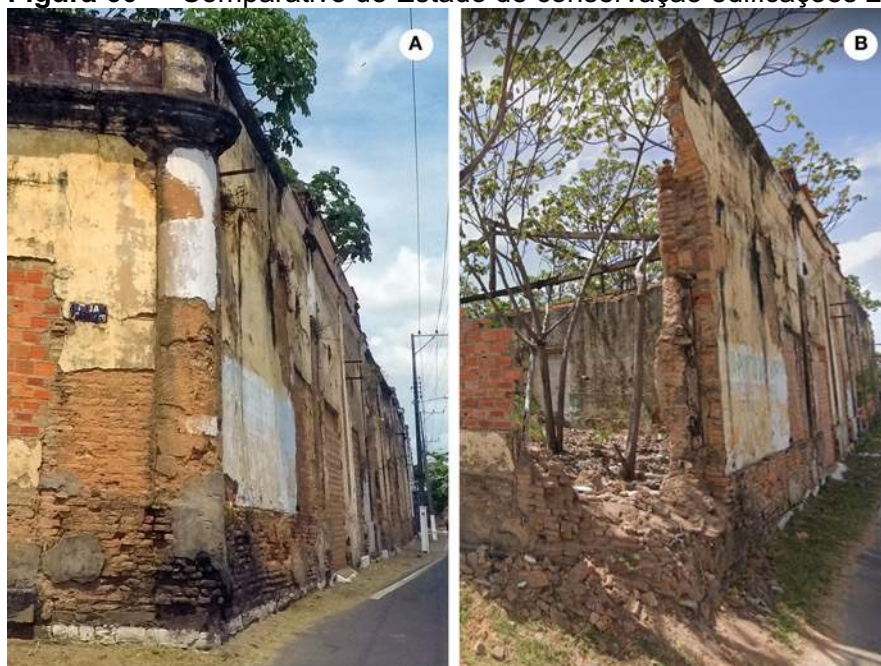
Figura 60 - Comparativo de Estado de conservação edificações 2019-2020
