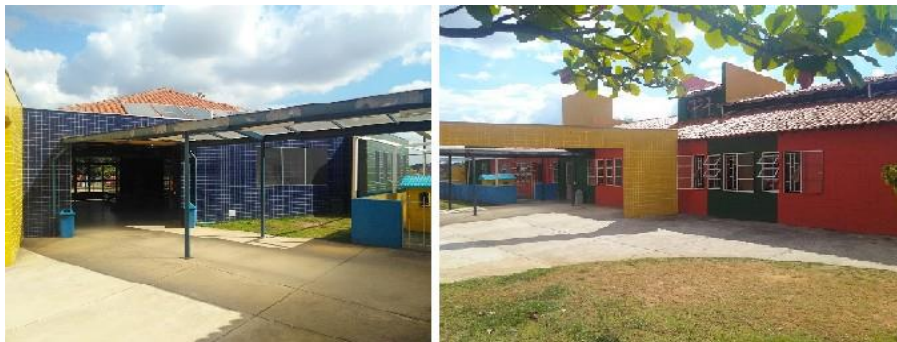
FIGURA 5 – CORREDOR DE LIGAÇÃO ENTRE OS BLOCOS
