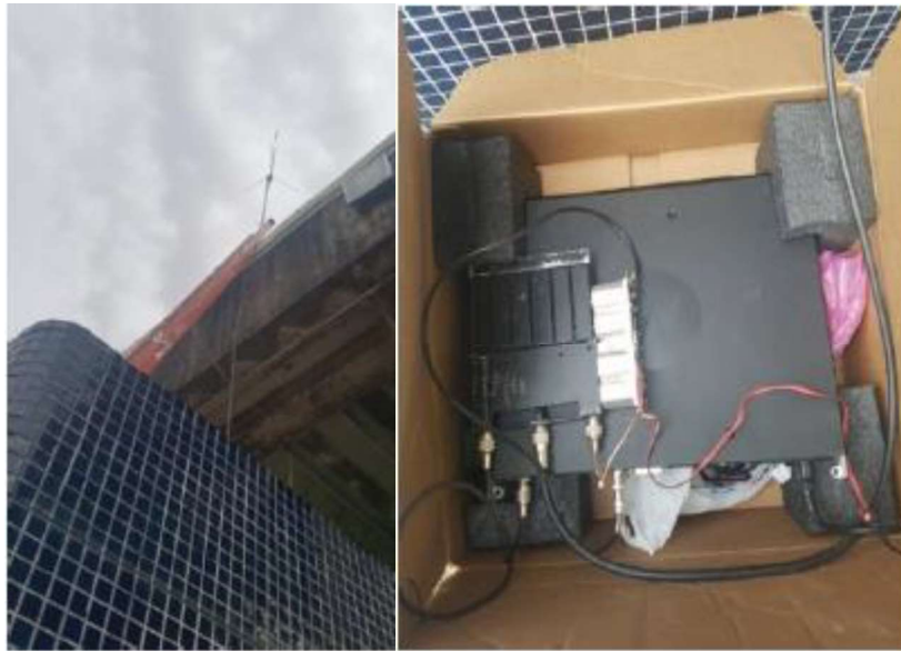
Figura A.11: Equipamentos do sistema de transmissão instalados em Eldorado.
