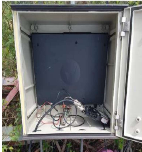
(b) Repetidora e duplexador instalados em um gabinete.
