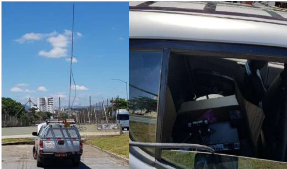
Figura A.15: Equipamentos do sistema de transmissão instalados em Waldomiro Lobo.
