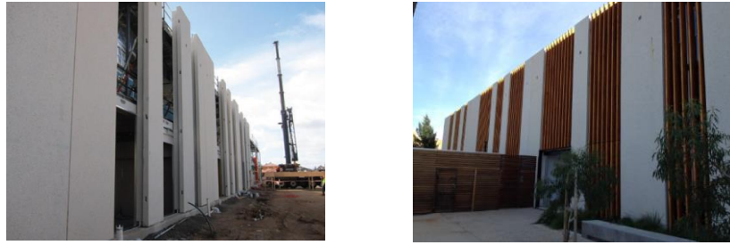
Figura 3.1.4 – Melton Library & Learning Hub na Austrália construído com pré-moldados e concreto usinado geopolimérico; à esquerda durante a obra e à direita a edificação pronta.
