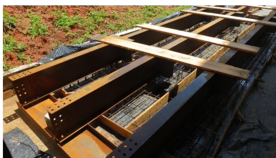
(a) Vigas posicionadas para concretagem
