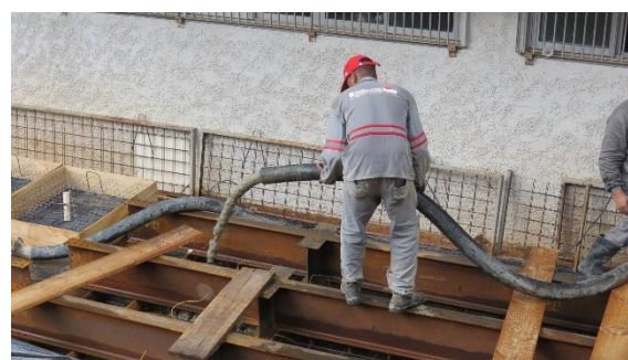
(b) Concretagem das vigas
