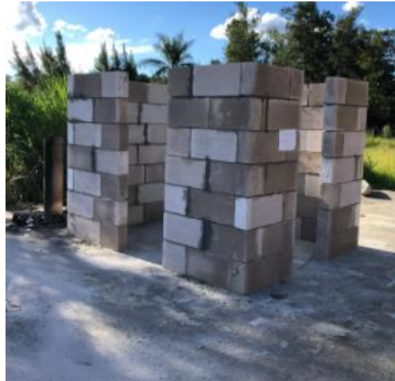
(b) Compartimento Construído
