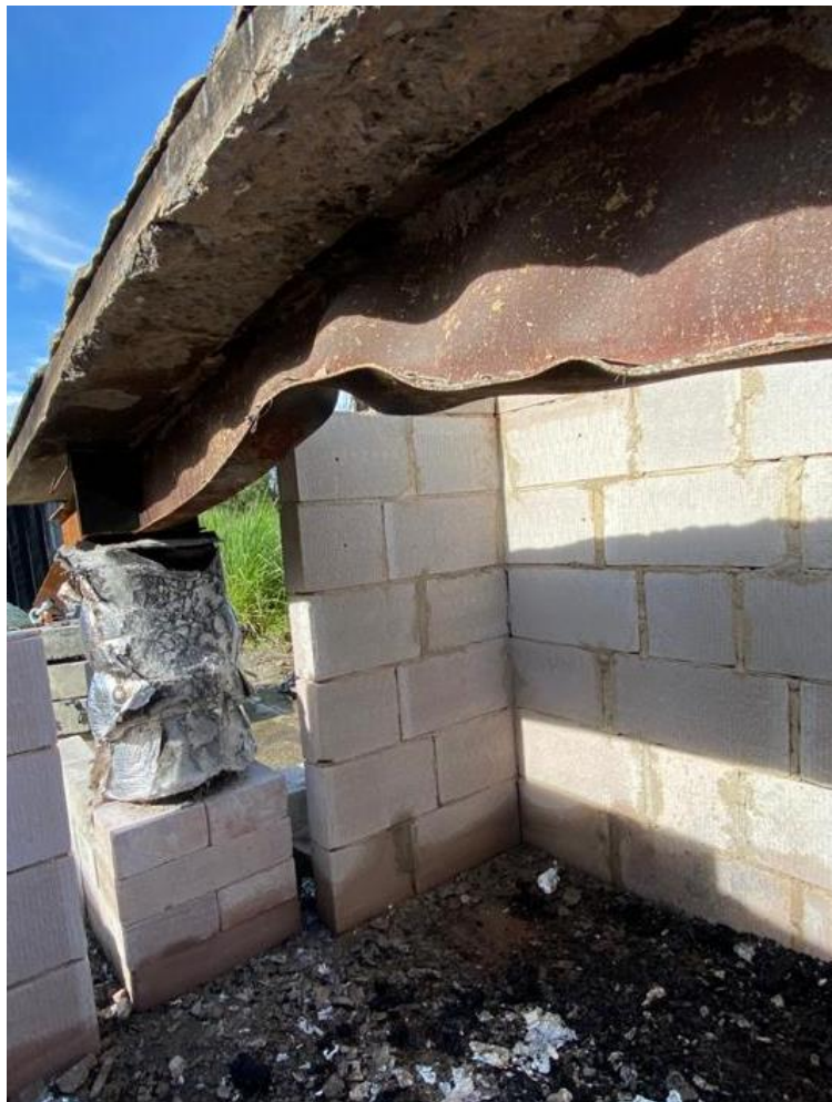
a) Viga ainda montada após o ensaio, com evidências de flambagem local da mesa e da alma.
