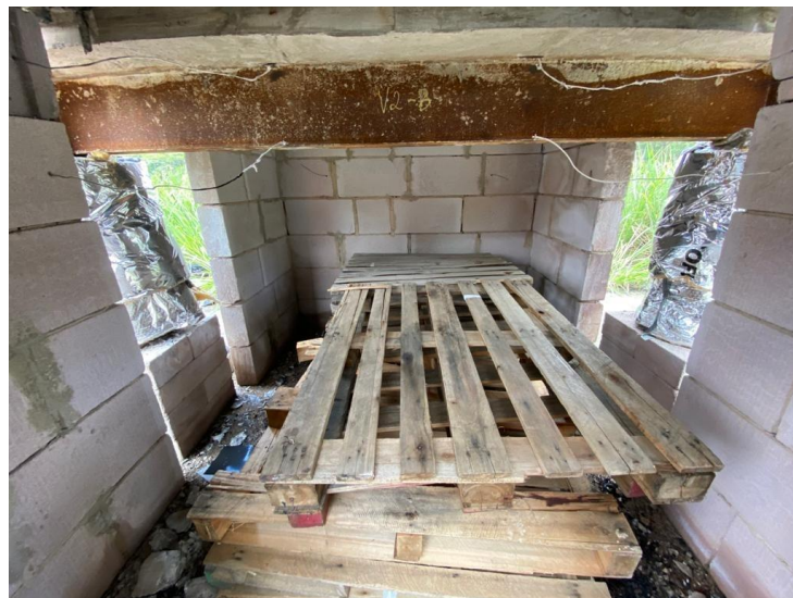
Figura 3-22 - Termopares soldados ao perfil para medição de temperaturas e parte da carga de incêndio posicionada.
