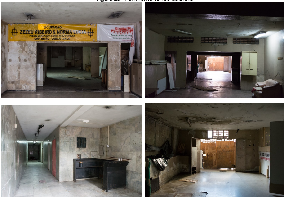
Figura 23 - Pavimento térreo da ZRNL
