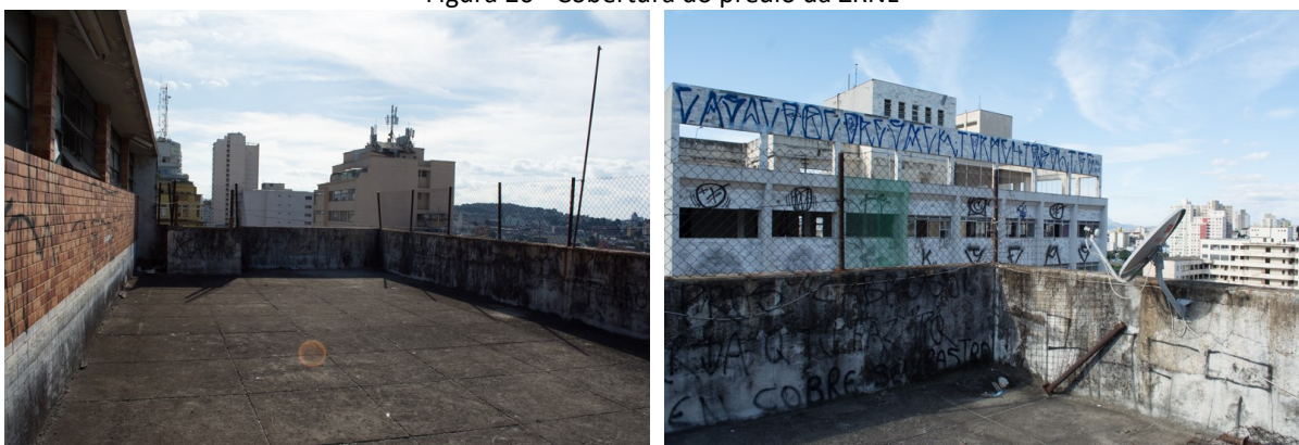
Figura 26 - Cobertura do prédio da ZRNL
