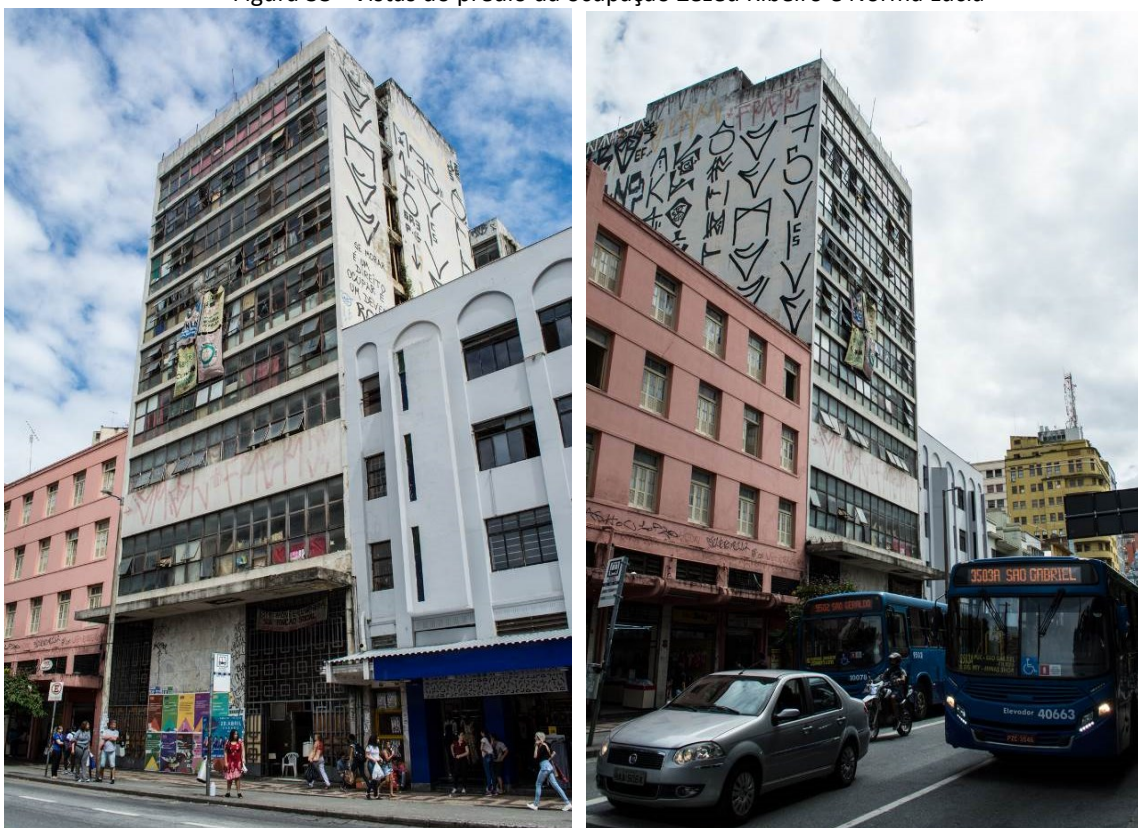
Figura 33 - Vistas do prédio da ocupação Zezeu Ribeiro e Norma Lúcia
