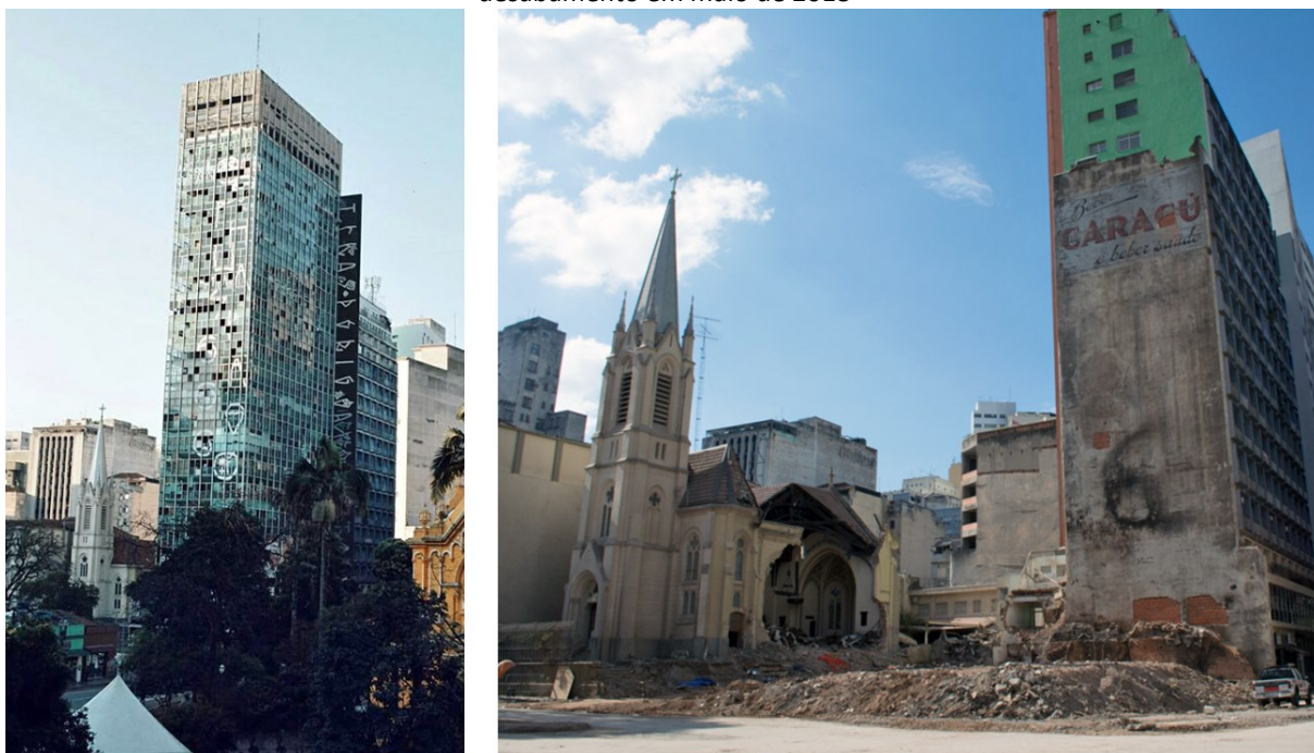
Figura 1 – Área do edifício Wilton Paes de Almeida (a) registro da ocupação em julho de 2016; (b) destroços do desabamento em maio de 2018
