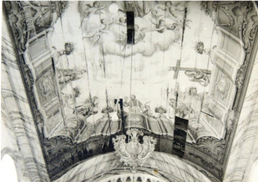
FIGURA 641: Detalhe do teto da nave da Capela de Nossa Senhora das Mercês, antes da primeira intervenção de restauração, realizada pelo IPHAN, década de 1960. CCRTAEM, IPHAN-RJ.
