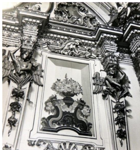
FIGURA 729: Aspecto da ilharga da capela-mor da Matriz de Nossa Senhora do Pilar, São João del-Rei-MG, painel pintado – vaso florido sobre pedestal, com volutas, guirlanda de flores e carrara, antes das intervenções de restauro. Fotografia do acervo da SR-IPHAN, Belo Horizonte-MG, 1958, sem registro de autoria.
