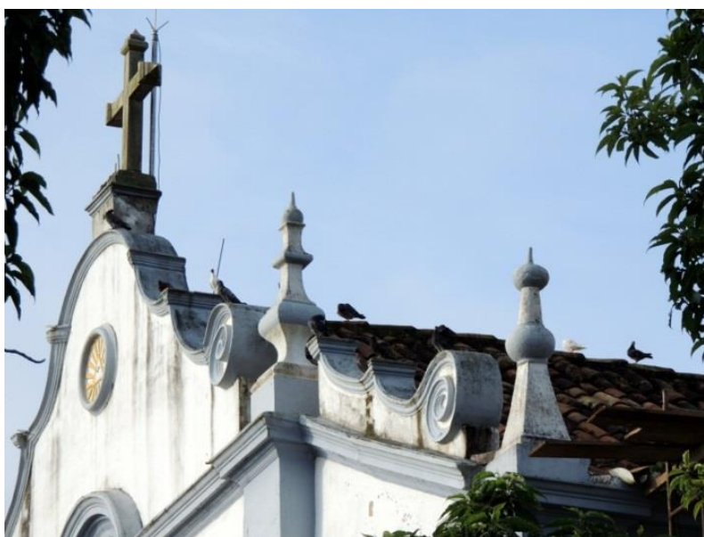
FIGURA 799: Detalhe da frontal da Capela da Santíssima Trindade, executada através de “riscos e planta” de autoria de Manoel Victor de Jesus, 1810, com destaque para as volutas e pináculos. Conforme “recibo”, EDSJDR, Museu de Arte Sacra de São João del-Rei-MG. Fotografia do autor, 2019.
