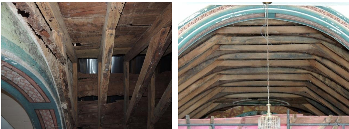
FIGURAS 517,518: Cambotas do teto da capela-mor, aparecendo o para-pó e a chapa metálica, para a proteção da pintura. Capela de Nossa Senhora do Pilar do Padre Gaspar, Elvas. Fotografias do autor, 2013.
