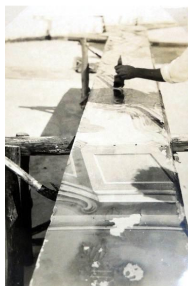
FIGURAS 679,680: Toda estrutura de madeira estava bastante comprometida, pela ação dos insetos. Capela de Nossa Senhora da Penha de França, Bichinho, Prados-MG. Obra atribuída a Manoel Victor de Jesus. Fotografias CCRTAEM, IPHAN-RJ, 1971.
