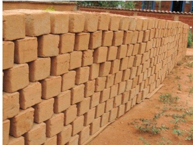
FIGURA 73: Produção de adobe, conforme a técnica tradicional, povoado do Bichinho. Material utilizado em obras de restauração de edificações e para obras novas. Prados-MG. Fotografia do autor, 2019.
