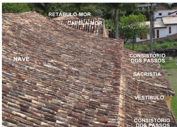
FIGURA 326: Telhado da Matriz de Santo Antônio, 2019. Indicação da localização dos tetos pintados. Fotografia do autor, 2019.
