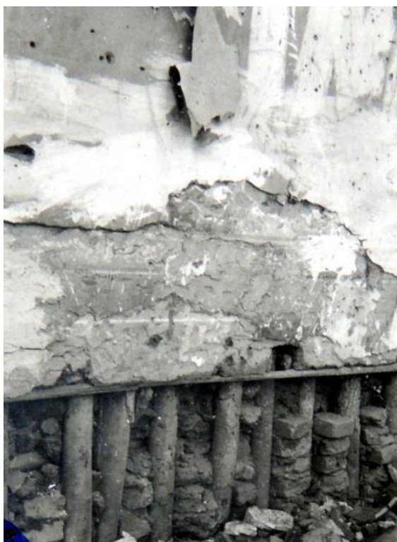
FIGURA 81: Parede de pau a pique com sucessivas camadas de reboco com pinturas ornamentais e também papel de parede. Casa do Espólio da Família Dias, atualmente o Centro Cultural Yves Alves, Tiradentes. Fotografia do autor, 1980.
