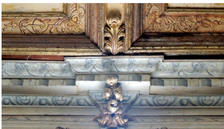
FIGURA 262: Cimalha da nave da Matriz, ornamentada com pintura marmórea. Têmpera sobre madeira, séc. XVIII. Fotografia do autor, 2019.
