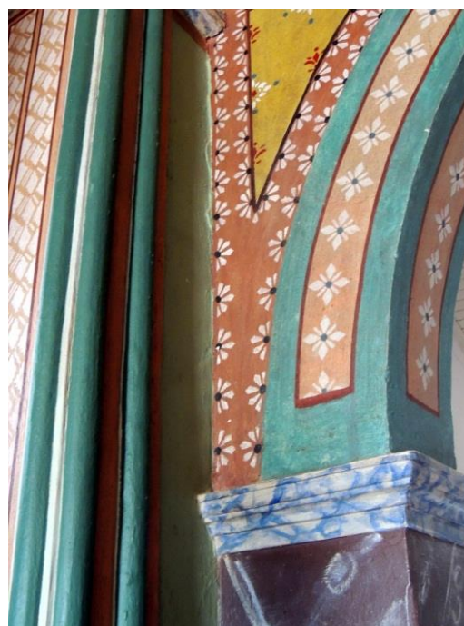
FIGURA 507: Aspecto da pintura do arco-cruzeiro, pintura de Francisco Cesário Coelho, têmpera sobre reboco, décadas de 1930/1940. Capela de Nossa Senhora do Pilar do Padre Gaspar, Elvas. Fotografia do autor, 2018.
