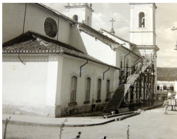
FIGURA 768: Aspecto da obra do telhado da Matriz de Nossa Senhora do Pilar, de São João del-Rei-MG. Fotografia acervo da SR-IPHAN, Belo Horizonte-MG, década de 1940.
