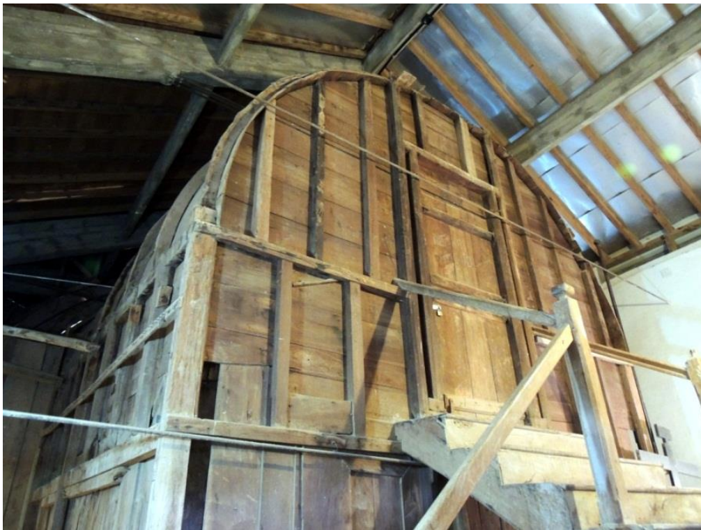
FIGURA 286: Aspecto externo da caixa do camarim, que abriga o trono-mor, com talha joanina. Matriz de Santo Antônio, Tiradentes-MG, c. 1750. Fotografia do autor.
