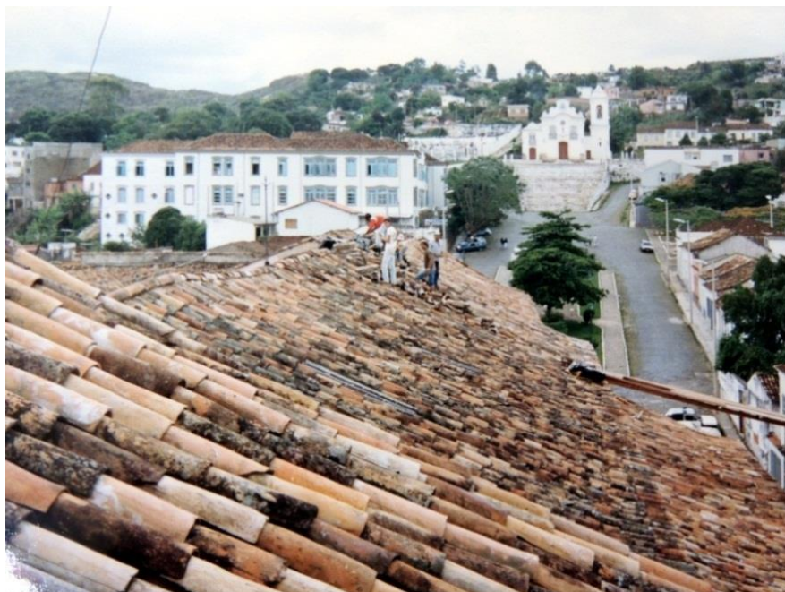
FIGURA 776: Obra no telhado da Matriz de Nossa Senhora do Pilar, São João del-Rei-MG. Fotografia do acervo da SR-IPHAN, Belo Horizonte-MG, 1987, sem ref. de autoria.
