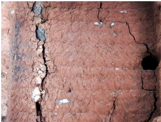
FIGURAS 488,489: Detalhes da parede de taipa e da portada em blocos de xisto verde. Capela do Padre Gaspar, Elvas. Fotografias do autor, 2013.
