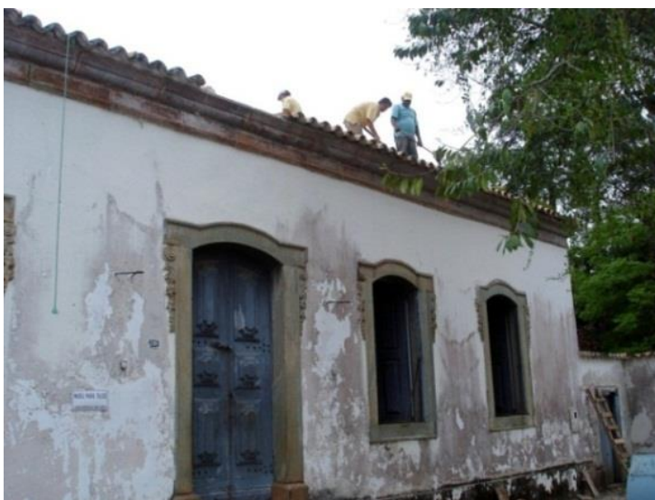
FIGURA 113: Início das obras de restauro arquitetônico e artístico da Casa Padre Toledo. Fotografia do autor, 2010.
