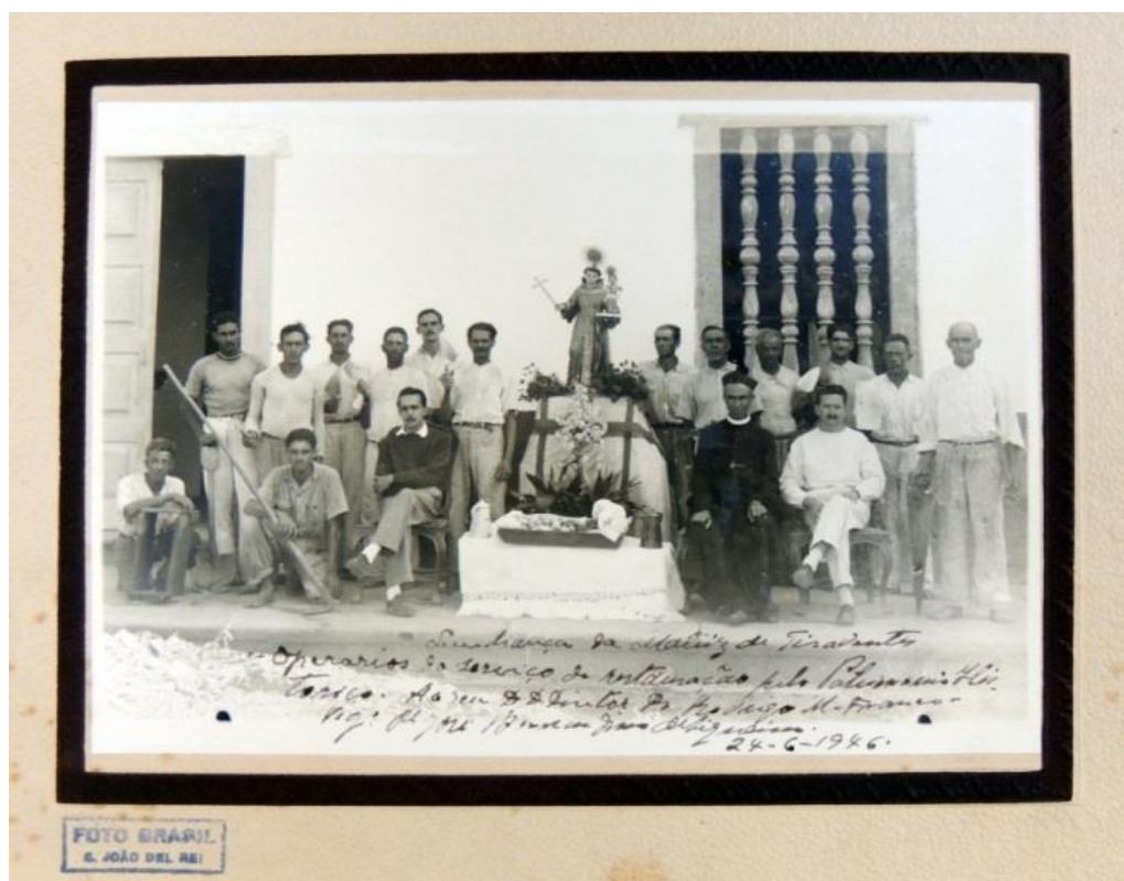
FIGURA 301: Equipe de trabalhadores, técnicos do IPHAN e o padre José Bernardino de Siqueira, primeira obra de restauração da Matriz de Santo Antônio, 1946. Foto Brasil, São João del-Rei-MG. ACIPHAN-RJ.
