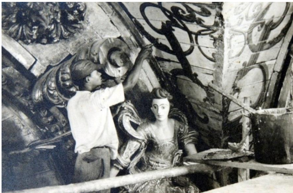
FIGURA 299: Restauração do teto da capela-mor, durante a intervenção de 1961. A aplicação da cera de abelha no teto da capela-mor. Matriz de Santo Antônio. Fotografia acervo do CCRTAEM, IPHAN-RJ.
