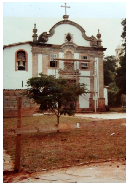
FIGURA 579: Capela de Nossa Senhora do Rosário, durante a obra da década de 1980. Fotografia do autor, 1982.
