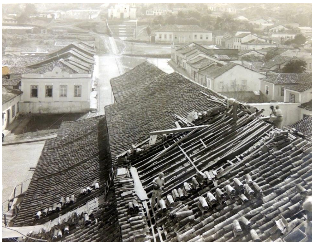
FIGURA 767: Aspecto da obra do telhado da Matriz de Nossa Senhora do Pilar, de São João del-Rei-MG. Fotografia acervo da SR-IPHAN, Belo Horizonte-MG, década de 1940.
