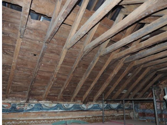
FIGURAS 519: Cambotas do teto da capela-mor, aparecendo o para-pó e a chapa metálica, para a proteção da pintura. Capela de Nossa Senhora do Pilar do Padre Gaspar, Elvas. Fotografia do autor, 2013.
