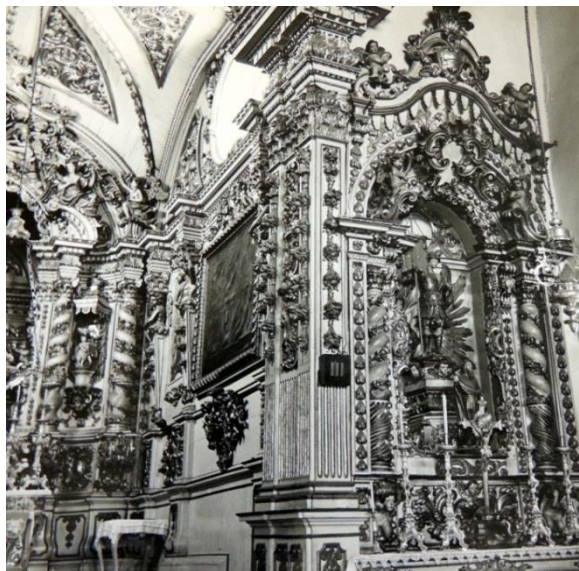
FIGURA 765: Muro da nave da Matriz de Nossa Senhora do Pilar, São João del-Rei-MG, com pintura padronizada, início do século XX. Fotografia acervo do IPHAN, SR-Belo Horizonte-MG, década de 1940, sem ref. de autoria.
