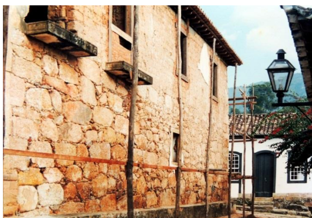
FIGURA 147: Fachada lateral do Sobrado Ramalho, durante a obra de restauração. Fotografia do autor, 1996.
