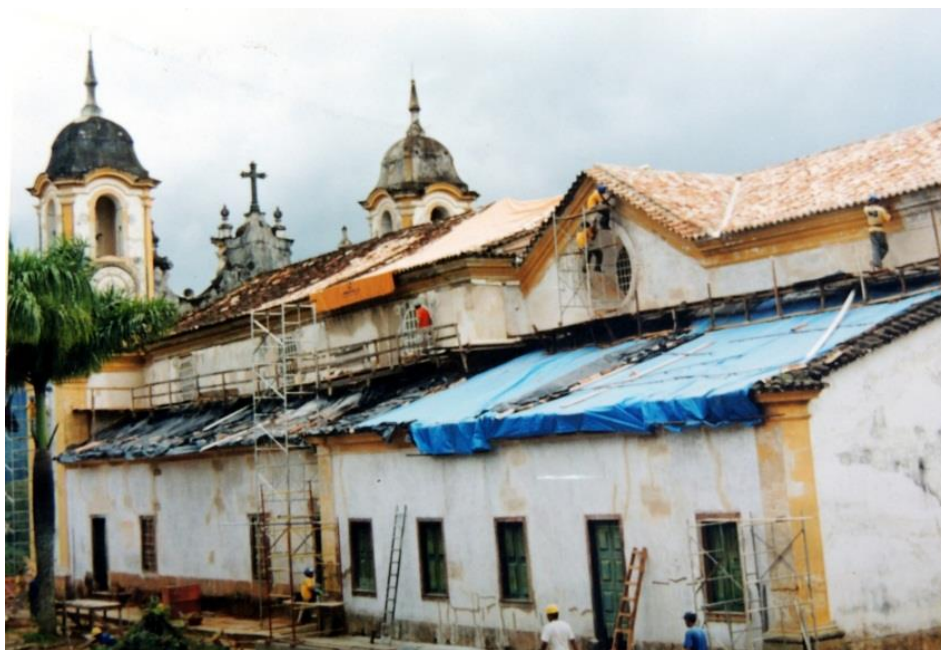
FIGURA 325: Obra estrutural e cobertura da Matriz de Santo Antônio, proposta pela Fundação Roberto Marinho, com apoio financeiro do BNDES. Fotografia do autor, 2002.
