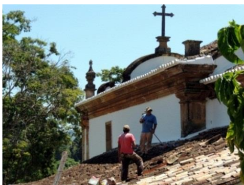
FIGURA 580: Fachada lateral da Capela de Nossa Senhora do Rosário, durante a obra de manutenção do telhado. Fotografia do autor, 2019.
