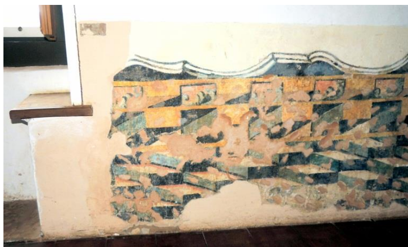
FIGURA 154: Detalhes da pintura do barrado imitando azulejaria, Sobrado Ramalho, provavelmente século XIX. Fotografia do autor, 2020.
