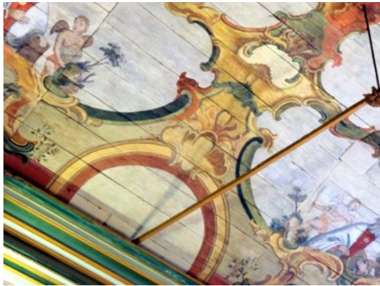
FIGURA 701: Detalhe do teto da nave da Matriz de Nossa Senhora da Conceição, séc. XVIII/XIX, após a obra de restauração, Prados-MG. Fotografia do autor, 2017.
