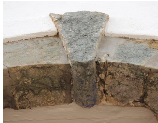
FIGURAS 488,489: Detalhes da parede de taipa e da portada em blocos de xisto verde. Capela do Padre Gaspar, Elvas. Fotografias do autor, 2013.
