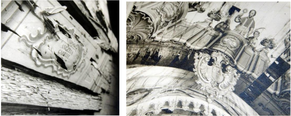
FIGURAS 638,639: Detalhes do teto da nave da Capela de Nossa Senhora das Mercês, antes da primeira intervenção de restauração, realizada pelo IPHAN, na década de 1960. CCRTAEM, IPHAN-RJ.
