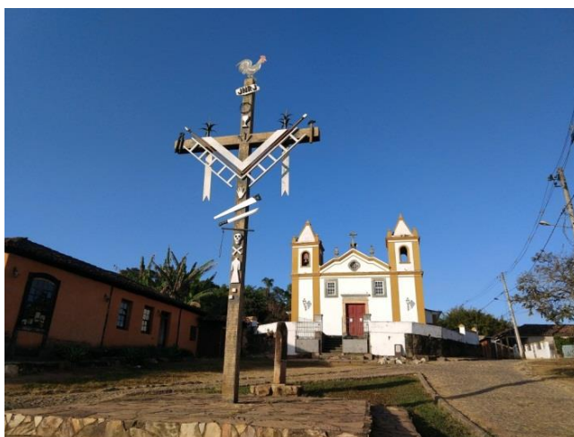
FIGURA 648: Fachada frontal da Capela de Nossa Senhora da Penha de França, séc. XVIII, Bichinho, Prados-MG. Fotografia do autor, 2019.
