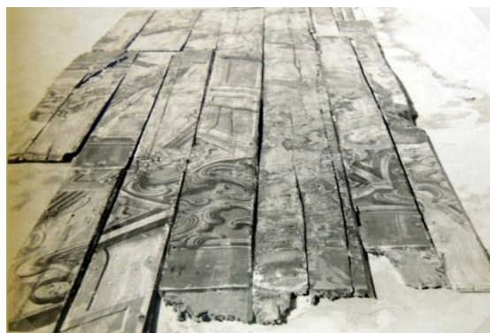
FIGURAS 679,680: Toda estrutura de madeira estava bastante comprometida, pela ação dos insetos. Capela de Nossa Senhora da Penha de França, Bichinho, Prados-MG. Obra atribuída a Manoel Victor de Jesus. Fotografias CCRTAEM, IPHAN-RJ, 1971.
