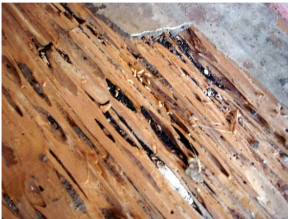
FIGURAS 121,122: Tábuas de teto da Casa Padre Toledo com a presença de insetos xilófagos e os danos que causaram. Fotografia do autor, 2010.
