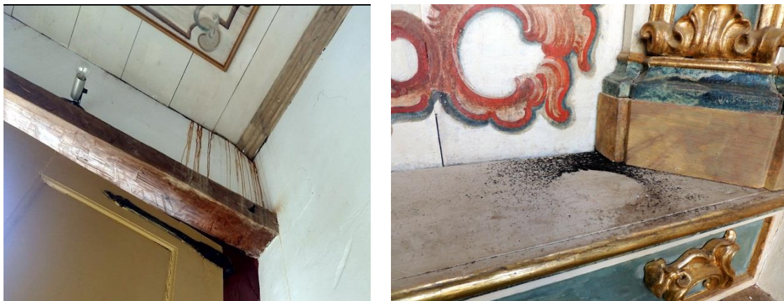
FIGURAS 215,216: Parede interna do Passo da Cadeia, 2019. Presença de insetos xilófagos no Passo da Rua Direita, com o Largo do Sol, 2019. Fotografias do autor.
