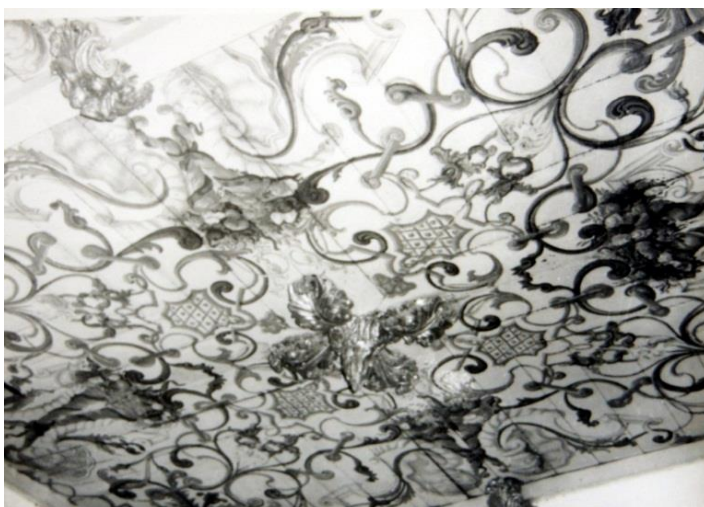
FIGURA 257: Matriz de Santo Antônio, teto do coro antes da intervenção de restauro, 1961. Fotografia do acervo do CCRTAEM-IPHAN, Rio de Janeiro.
