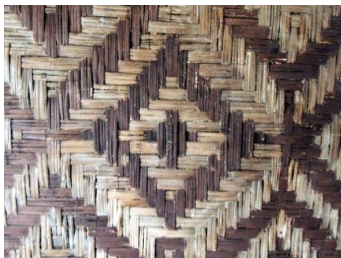
FIGURA 77: Teto de esteira de bambu pintada, com desenhos geométricos. Casa da Caixa D'Água, Tiradentes-MG, séc. XIX. Fotografia do autor, 2017.
