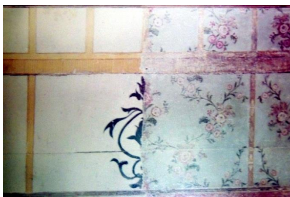
FIGURA 682: Registro do processo de remoção da repintura do frontão de um dos retábulos, Capela de Nossa Senhora da Penha de França, Bichinho, Prados-MG. Obra atribuída a Manoel Victor de Jesus. Fotografia CCRTAEM, IPHAN-RJ, 1971.
