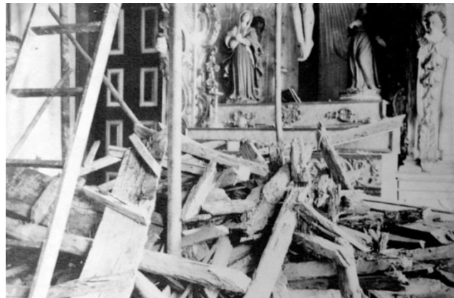
FIGURA 464: Aspecto da obra de restauração do teto artesoado e do telhado do Consitório da Irmandade do Senhor dos Passos. Fotografia do CCRTAEM-IPHAN, Rio de Janeiro, década de 1960.
