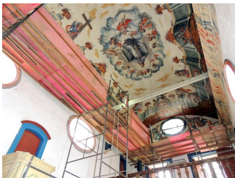
FIGURA 645: Aspecto do teto da nave durante a obra de restauração, 2012-2015. Capela de Nossa Senhora das Mercês. Fotografia do autor, 2015.
