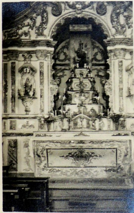
foto 2 - Trôno de N. S. PENHA decorado com pintura a têmpera nas partes lisas. Grande parte está descolando e outras estão repintadas.
