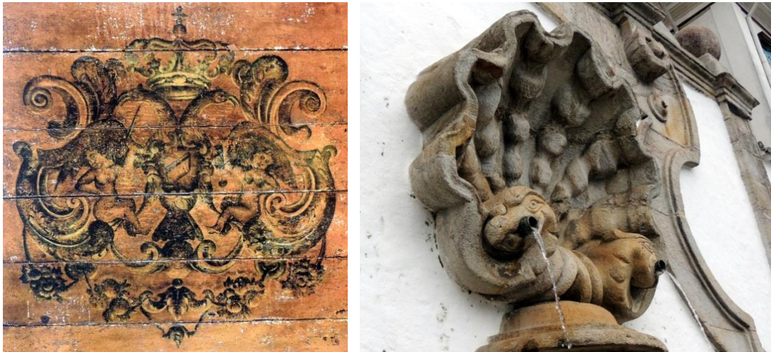
FIGURAS 88,89: Detalhe do teto da antiga casa de Manoel Manso da Costa Reis, em tabuado liso, têmpera sobre madeira, século XVIII e detalhe do Chafariz dos Contos, de 1745, com cabeças de águias. Fotografias do autor, 2019.
