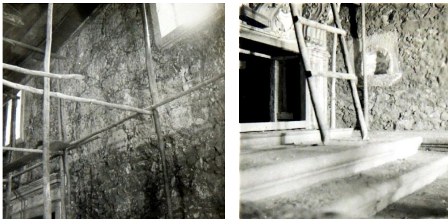
FIGURAS 572,573: Aspectos da obra de restauração da Capela de N. S. do Rosário, substituição dos revestimentos, deixando à mostra as paredes de pedra, década de 1940. ACIPHAN-RJ.
