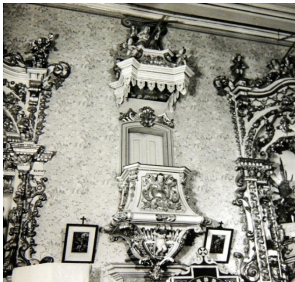
FIGURA 764: Pintura padronizada nas paredes da nave da Matriz de Nossa Senhora do Pilar, São João del-Rei-MG, encobertas na primeira obra de restauração realizada pelo IPHAN. Fotografia acervo SR- IPHAN, Belo Horizonte-MG, década de 1940, sem ref. de autoria.
