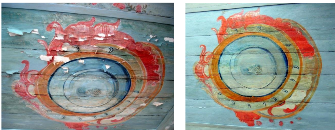
FIGURA 779,780: Teto do vestíbulo à esquerda, em crítica situação de conservação em consequência do excesso de umidade; têmpera sobre madeira, século XVIII/XIX; e após a intervenção de restauração. Matriz de Nossa Senhora do Pilar, São João del-Rei-MG. Fotografias do autor, 2011 e 2019.
