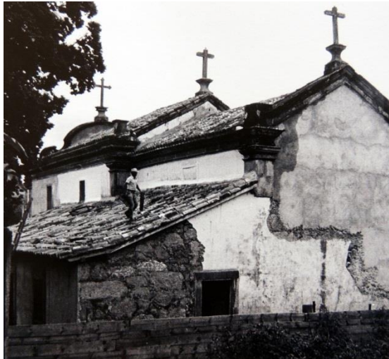
FIGURA 578: Fachada lateral e posterior da Capela de Nossa Senhora do Rosário, durante a obra da década de 1980. Acervo ACIPHAN-Rio de Janeiro, 1981, sem ref. de autoria.
