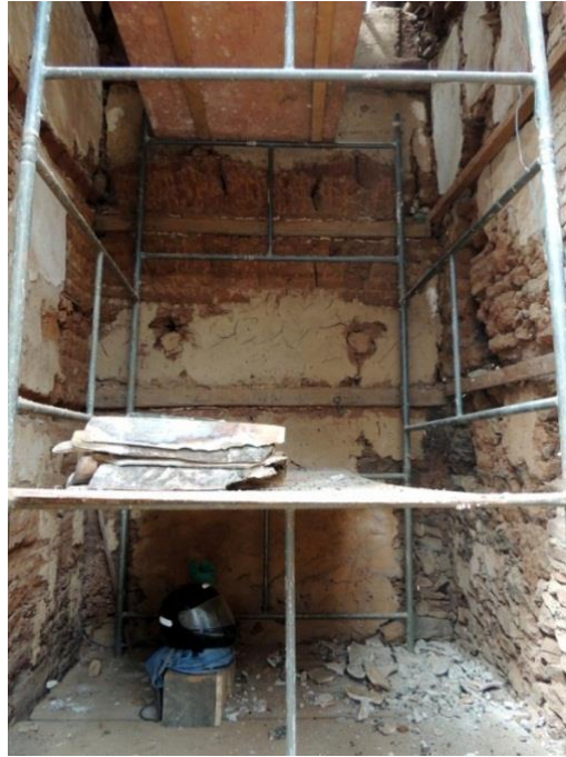
FIGURA 186: Passo da Paixão da Rua Direita, durante a obra de restauro estrutural e artístico. Fotografia do autor, 2017.
