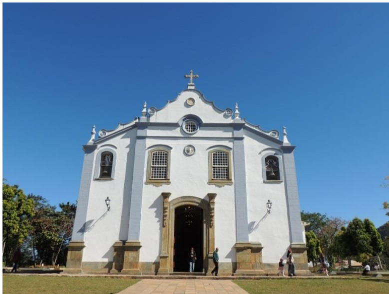
FIGURA 798: Fachada frontal da Capela da Santíssima Trindade, executada através de “riscos e planta” de Manoel Victor de Jesus, 1810. Conforme “recibo”, EDSJDR, Museu de Arte Sacra de São João del-Rei-MG. Fotografia do autor, 2019.
