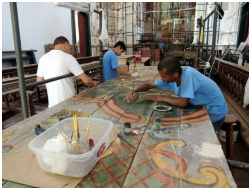
FIGURA 523: Teto da capela-mor durante o processo de restauração, na Capela de São João Evangelista. Fotografia do autor, 2013.
