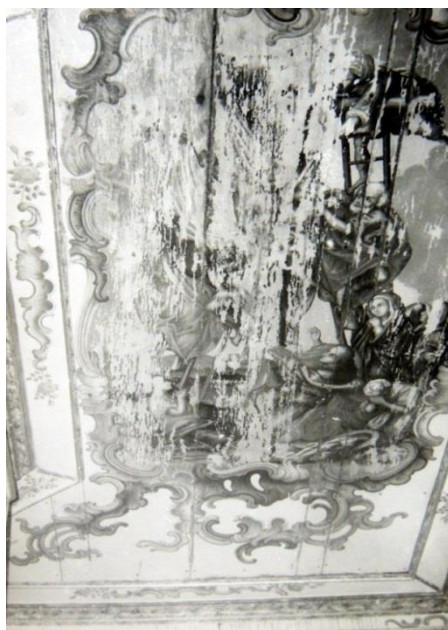
FIGURA 305: Teto do consistório da Irmandade do Senhor Bom Jesus do Descendimento, danificado por águas pluviais. Pintura de Manoel Victor de Jesus, 1786. Fotografia década de 1960, CCRTAEM, IPHAN-RJ.
