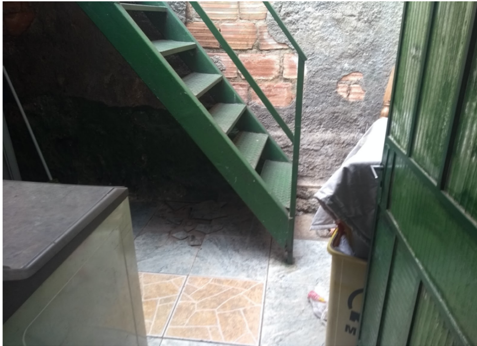
Figura 4: Foto do muro de divisa do lado do imóvel 1
