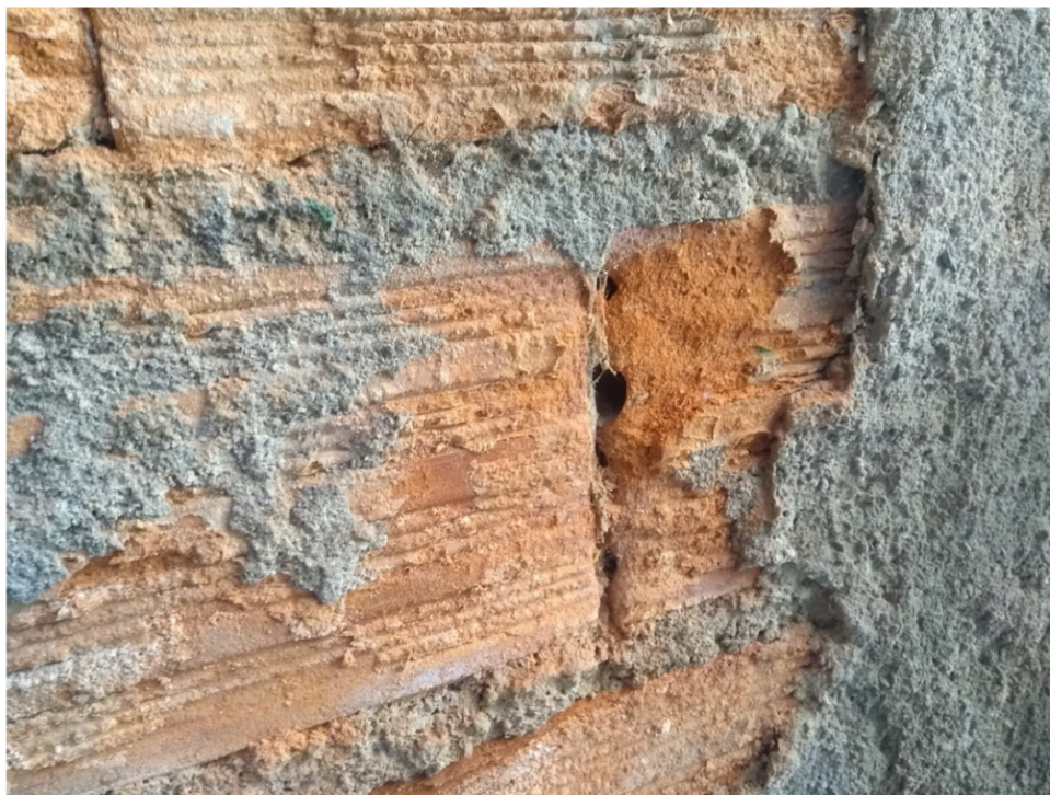
Figura 5: Foto do muro de divisa do lado do imóvel 1
