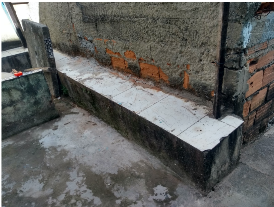
Figura 6: Foto do muro de divisa do lado imóvel 2
