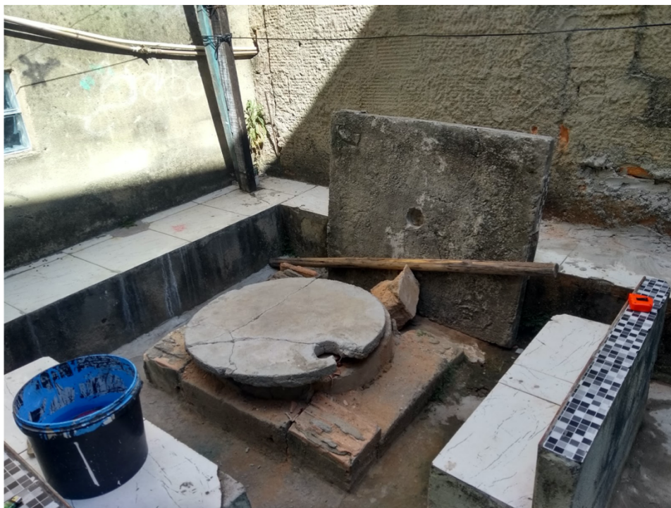
Figura 7: Foto de fossa no imóvel 2 próxima do muro de divisa
