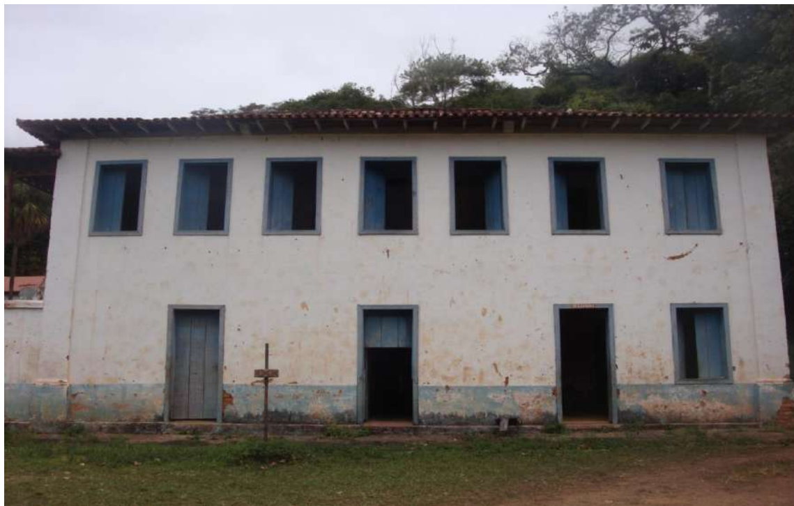
FIGURA 6 - Fachada da sede da Fazenda Guarani, onde funcionava a sede da administração policial e o presídio
