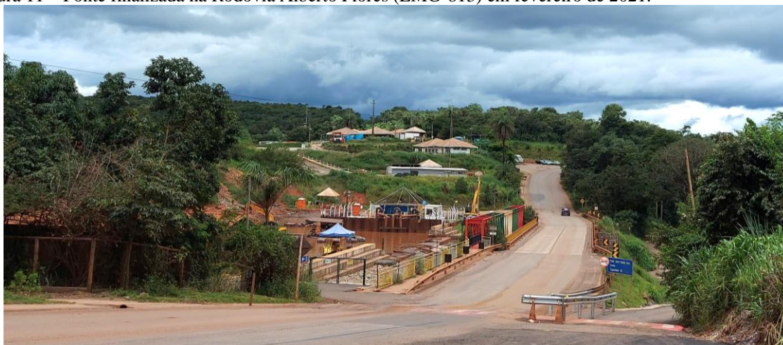
Figura 11 – Ponte finalizada na Rodovia Alberto Flores (LMG-813) em fevereiro de 2021.
