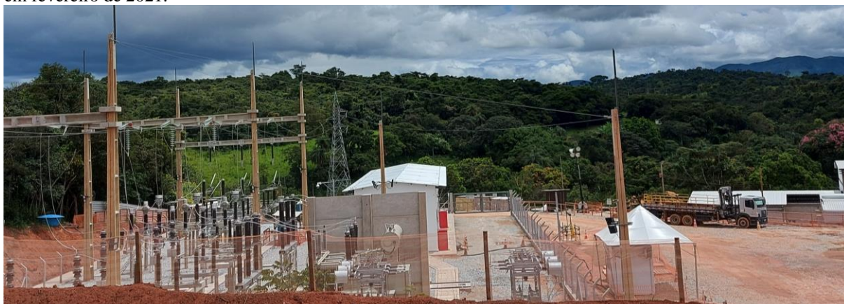
Figura 13 – Obras de construção da nova captação no Rio Paraopeba. Subestação para alimentação das bombas em fevereiro de 2021.
