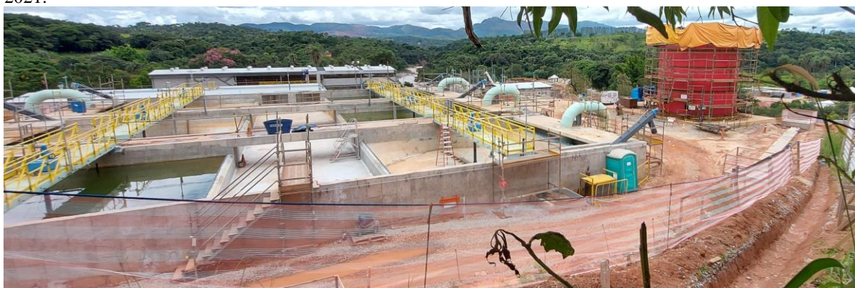
Figura 12 – Obras de construção da nova captação no Rio Paraopeba. Tanques de bombeamento em fevereiro de 2021.
