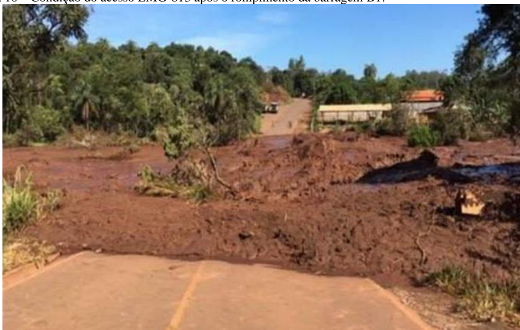
Figura 10 – Condição do acesso LMG-813 após o rompimento da barragem B1.
