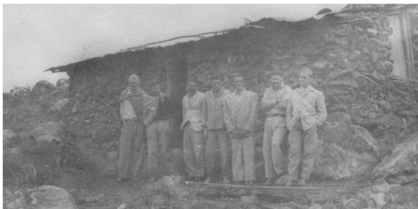
FIGURA 24 – Casa de pedra no Terreirão. Originalmente construída para abrigar os campeiros. Tornou-se um importante espaço de sociabilidade. Década de 1950. FONTE: IBGE/RJ
