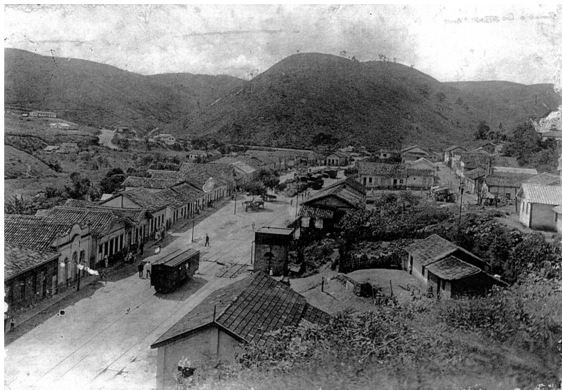
FIGURA 18 - Rua principal de Caparaó. Estação Ferroviária com vagão ao centro. Desta estação era despachada a madeira de Alto Caparaó para o Rio de Janeiro. Foto da década de 1960, aproximadamente. FONTE: Projeto Caparaó – Coltec/UFMG
