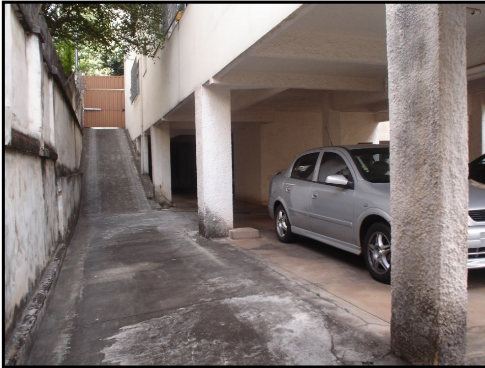
Fotografia 3: Vista da rampa de acesso ao local periciado (garagem do edifício)
