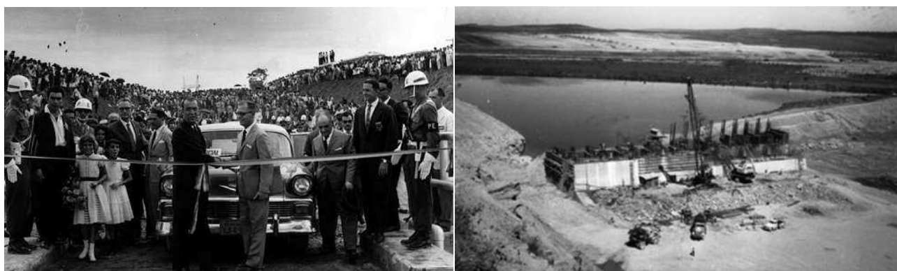
Figura 2 – Inauguração da barragem da UHE de Três Marias por JK (à dir.) e construção da barragem da UHE de Três Marias (à esq.) (4).
